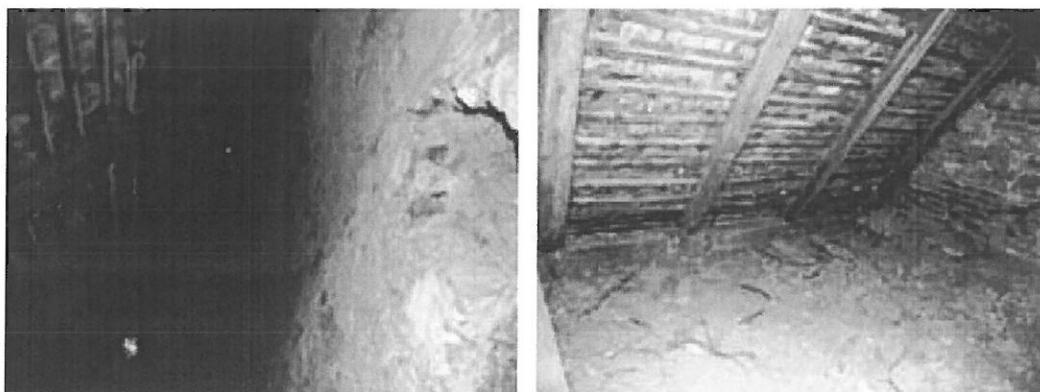
Foto nr.104,105 Șarpantă adiacentă de nord
