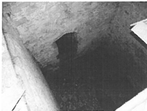
Foto nr.98 Primul nivel-zidărie
