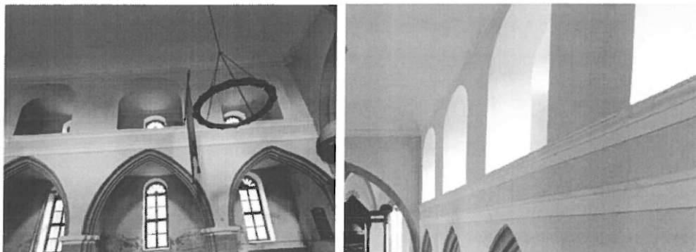
Foto nr.34,35 Galerii laterale de nord și de sud
