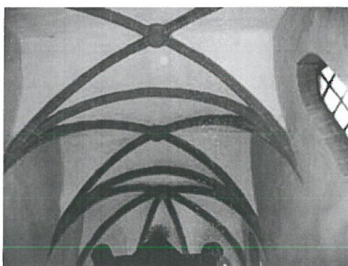
Foto nr.40 Tavan în stare bună de conservare
