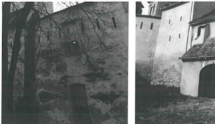
Foto nr.10,11 Umiditate ascensională, pe exterior
