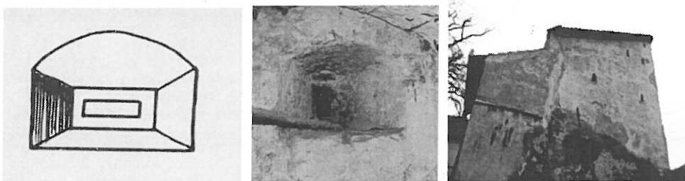
Fig.53-55. Metereze orizontale pentru pușcași (Turnul de nord)
