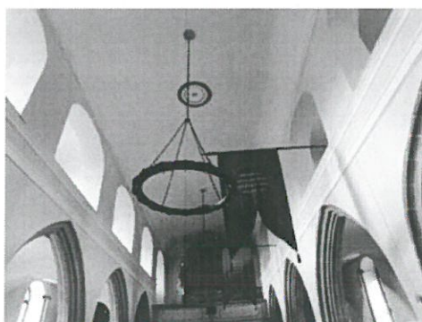
Foto nr.29 Tavan în stare bună de conservare
