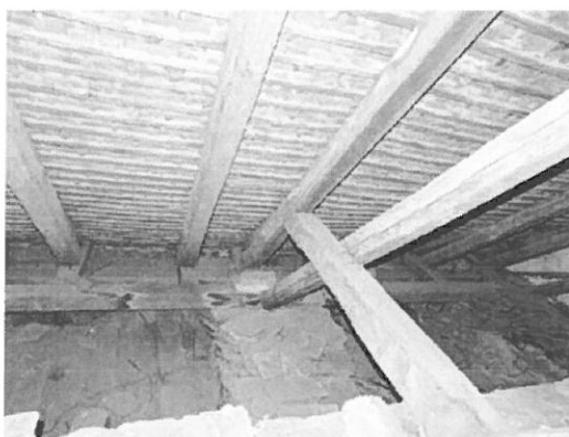
Foto nr.83 Țigle depozitate pe boltă
