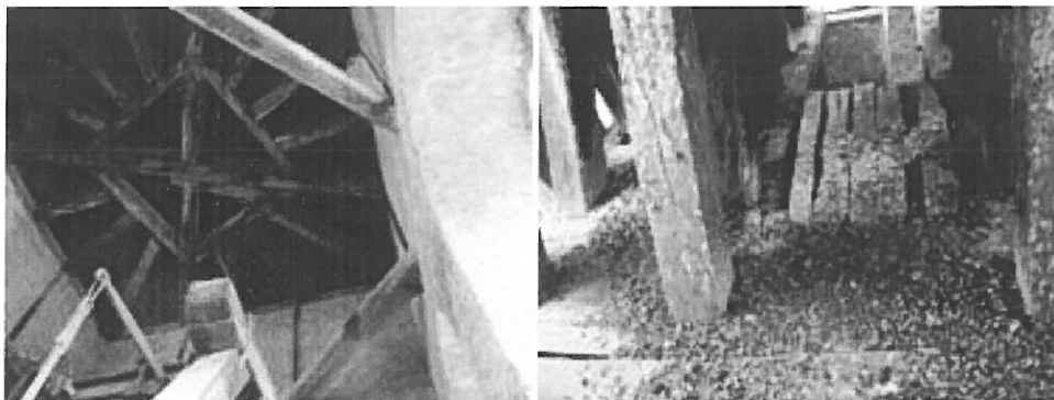
Foto nr. 120, 121 Șarpantă turn și ultimul nivel
