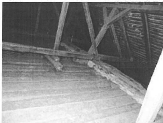
Foto nr.84 Bolta podita cu scandura de brad
