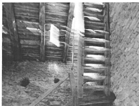
Foto nr. 125 Scara de acces în nivel II
