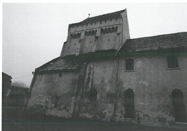
Fig.11. Vedere cu sacristia
