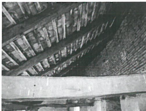
Foto nr. 153 Șarpantă drum de strajă
