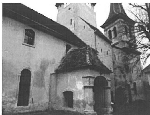
Foto nr.101 Șarpante adiacentă de nord-turn
