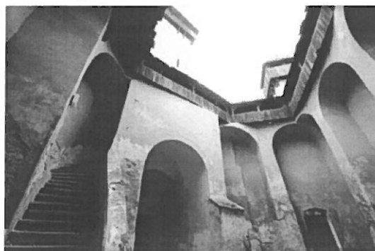
Fig.22. Scara de acces din Curtea fântânii spre coridorul de apărare și intrarea din peretele sudic
