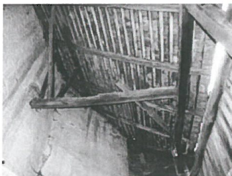
Foto nr. 152 Șarpantă drum de strajă
