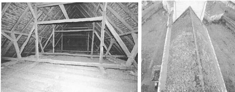
Fig.47-48. Șarpanta acoperișului peste nava și colateralele bisericii
