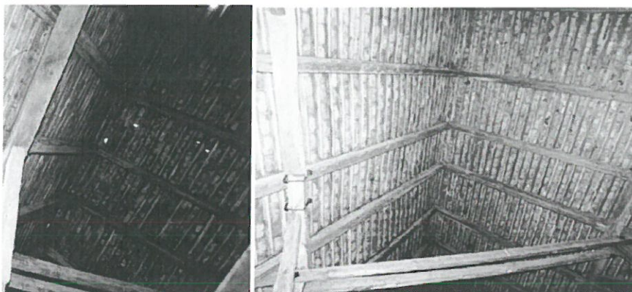
Foto nr. 62,63 Coame-se observă unele mici halouri de umiditate
