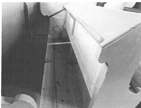
Foto nr.30 Zone cu halouri uscate, de umiditate
