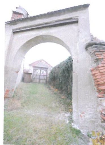
Foto 23 - Foto Vedere spre accesul nord-estic
