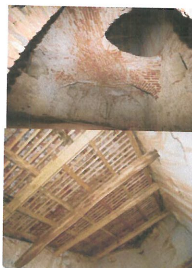
Foto 17,18,19 -Turnul de nord – vedere, Boltă între nivelul doi și trei desfăcută/ prăbușită, șarpanta
