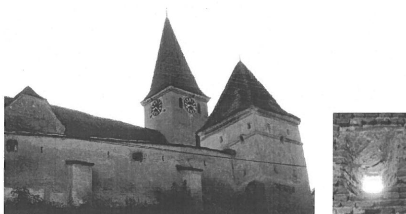
Fig. 24-25. Metereze simple și guri de turnare la zidul de incintă și Turnul de nord
