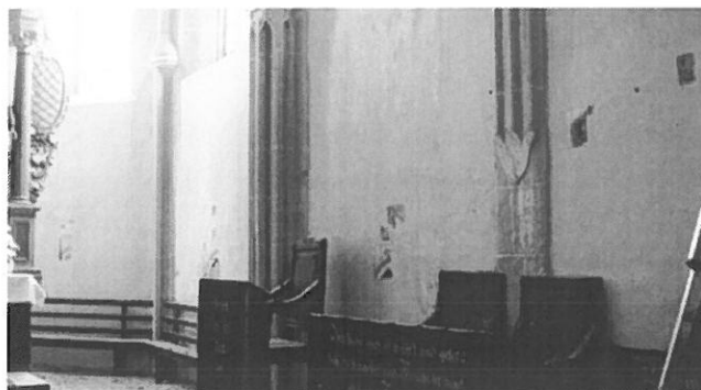
Fig.40. Nișe înzidite localizate în pereții corului în urma studiilor de parament 1
