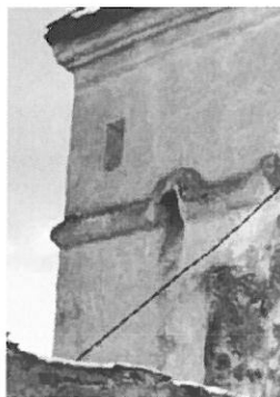
Fig. 36. Turnul de nord - detaliu cornișă de piatră
