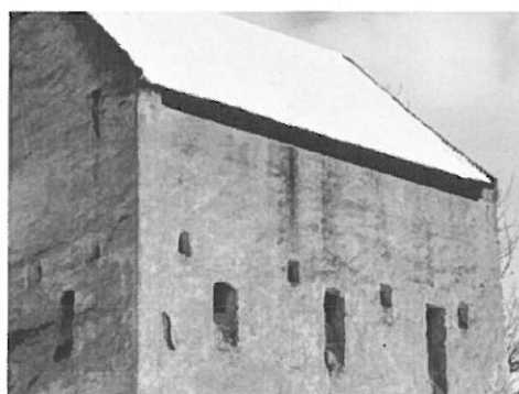
Fig. 23. Metereze simple și guri de turnare la turnul de sud-est
