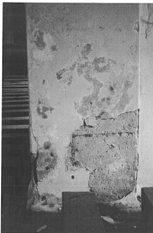
Pilastrul „arcului triumfal al transeptului nordic. La îndepărtarea tencuielii cu ciment s-au făcut vizibil blocurile din piatră fasonată.
