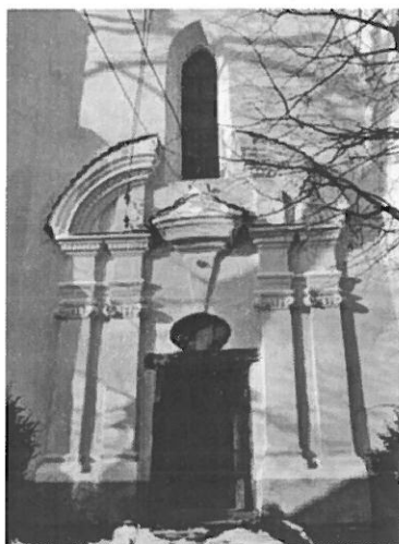
Fig. 51. Intrarea principală pe fațada sudică
