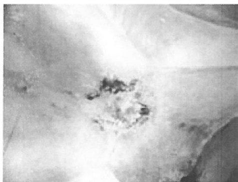
Foto nr. 39, 40 Halouri de umiditate pe tavan
