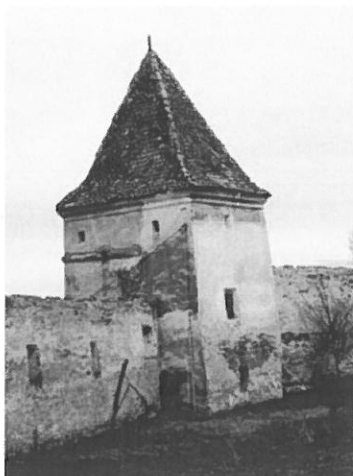
Foto nr. 108 Turn de sud-vest-vedere generală
