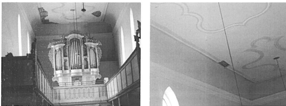
Foto nr. 24, 25 Halouri de umiditate pe tavan
