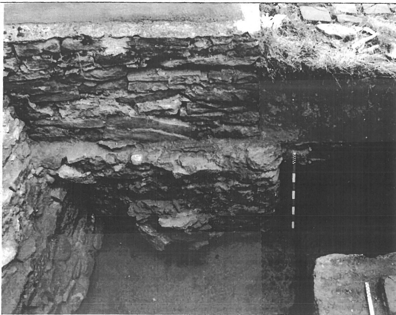
Fig. 6b. C2 – detaliu cu fundațiile laturii de nord a navei și a contrafortului adosat
