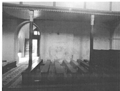
Foto Nr 20,21 Umiditate ascensională interior biserică
