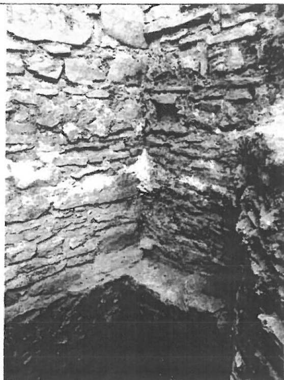
Fig. 4a. C1 – detaliu fundație a laturii de sud a turnului și a laturii de vest a navei
