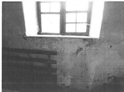
Foto nr.22,23 Infiltrații în zona ferestrelor
