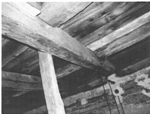
Foto nr.106 Elemente cu atac de insecte xilofage în zona de alburn
