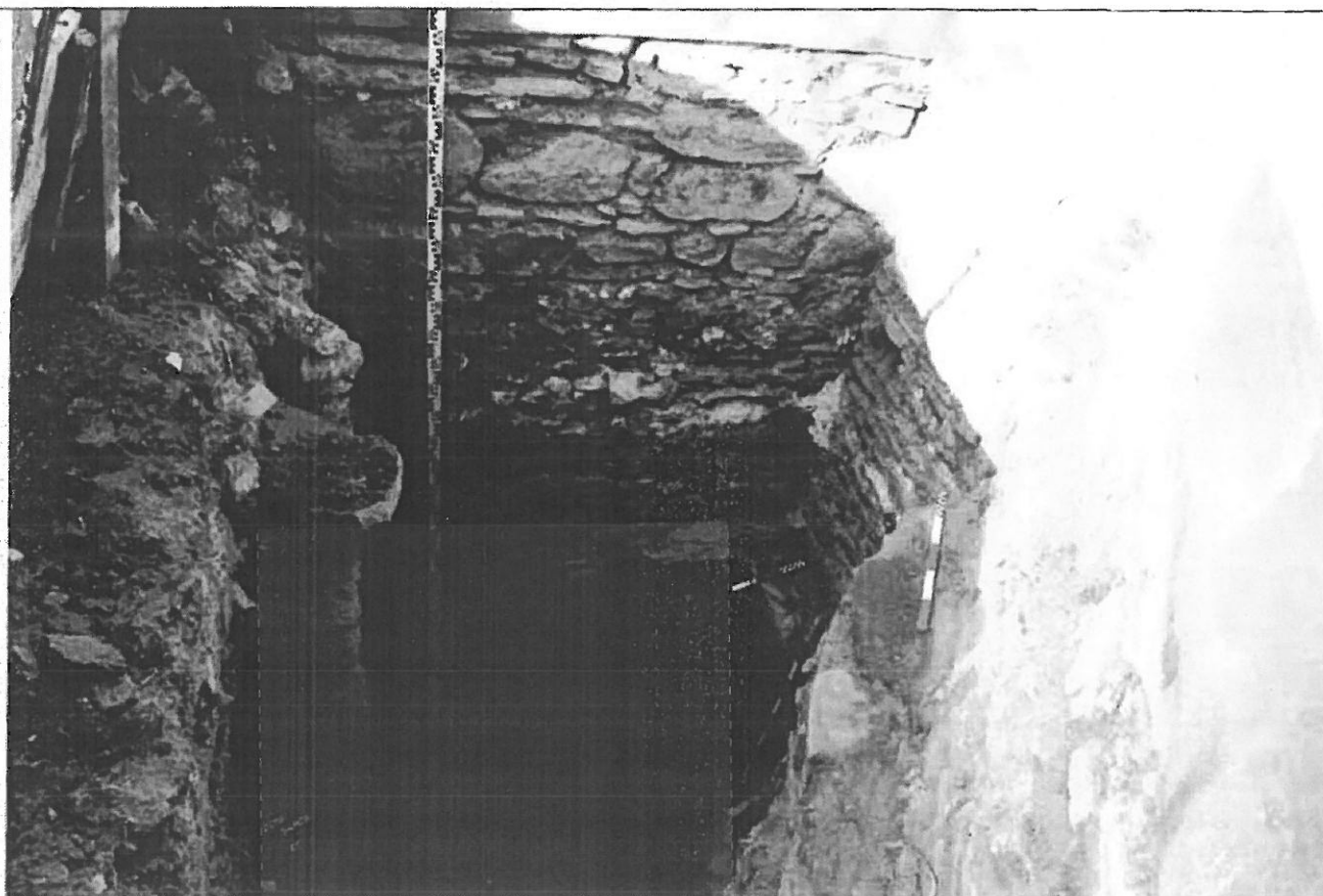
Fig. 4b. C1 – detaliu fundație a laturii de sud a turnului și a laturii de vest a navei
