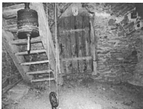
Foto nr.93 Primul nivel-zidărie
