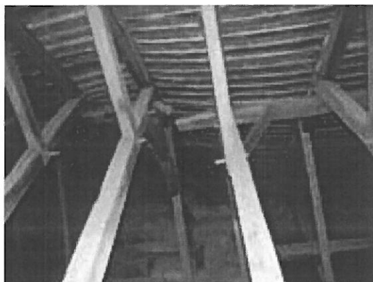
Foto nr.76 Bolti cu materiale de construcție
