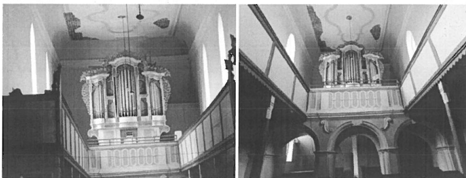
Foto nr.43,44 Balcon confecționat din zidărie-central și lateral- lemn de brad
