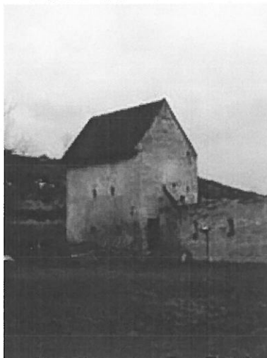
Foto nr.116 Turn de nord vest-vedere generală
