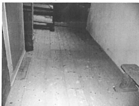
Foto nr.29 Halouri de umiditate vechi, uscate la podea balcon
