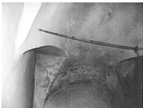
Foto nr. 39, 40 Halouri de umiditate pe tavan
