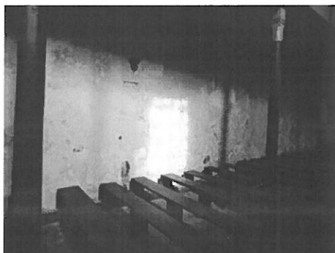
Foto Nr 20,21 Umiditate ascensională interior biserică
