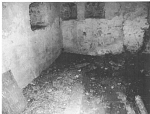
Foto nr.123 Pardoseală turn
