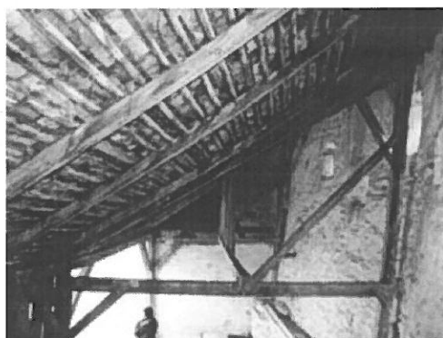
Foto nr.124 Șarpantă adiacentă turnului
