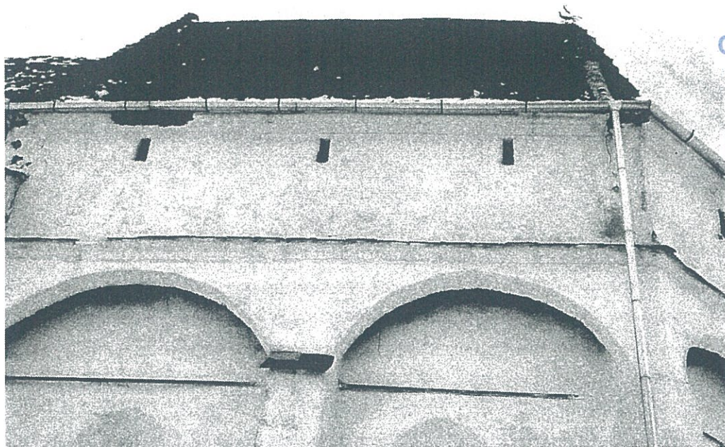
Etajul fortificat al turnului. În zona unde tencuiala cornișei s-a pierdut, se observă zidăria de cărămidă.
