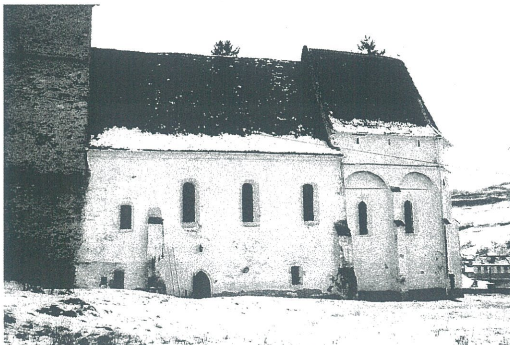
Latura sudică a bisericii cu etajul fortificat al altarului
