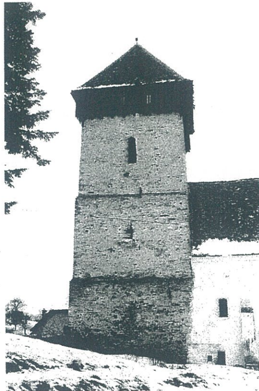
Latura sudică a turnului.
