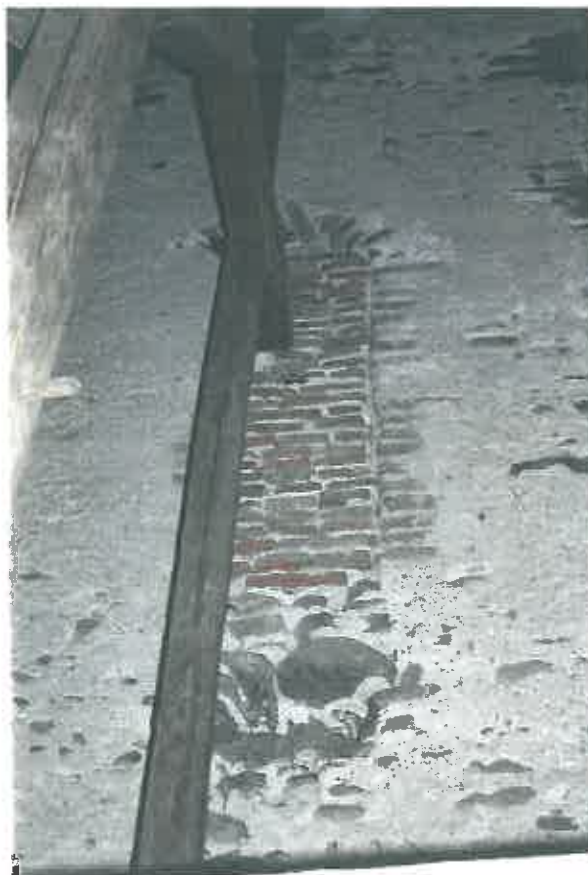
Latura estică a turnului, zona podului: fereastră romanică înzidită.
