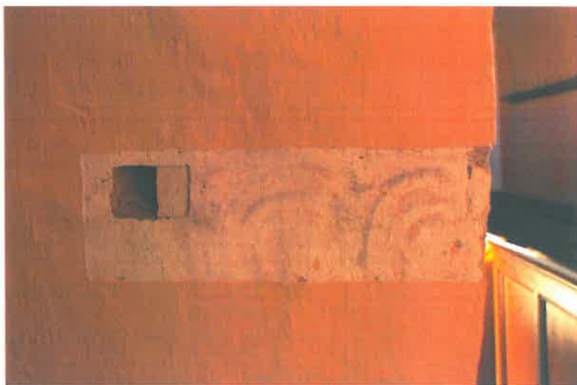
Intradosul arcului dintre nava principală și cea laterală sudică: sondaj stratigrafic cu urmele unei picturi decorative.
