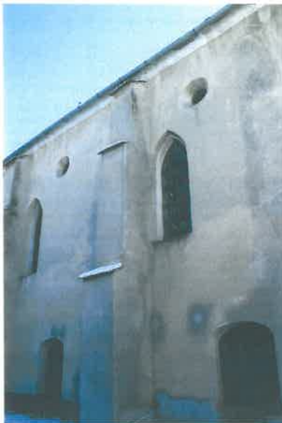
Latura nordică a navei
