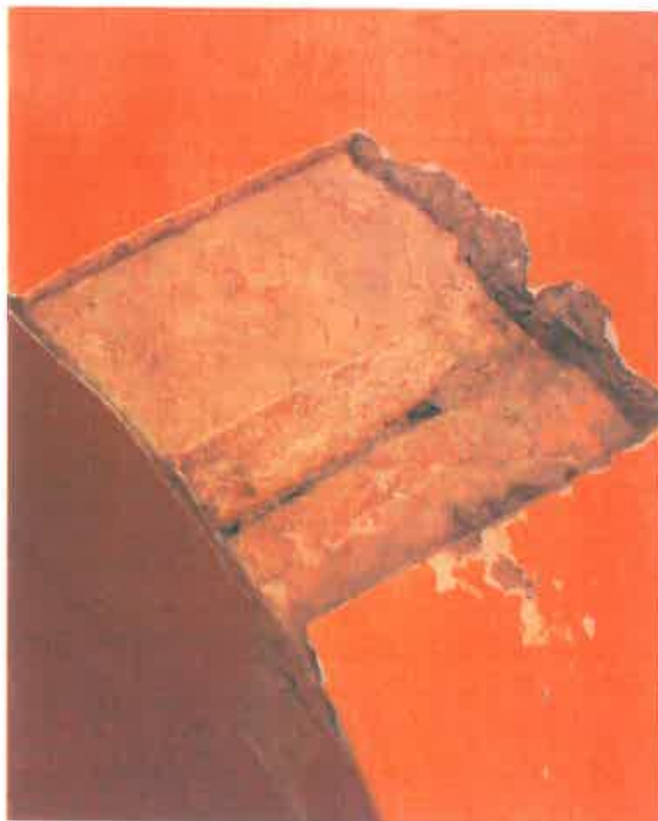
Portalul sudic. Sondaj stratigrafic pe chenarul semicircular din piatră fasonată.
