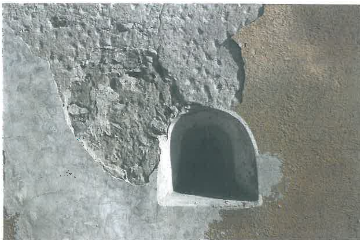
Fațada vestică: fereastră romanică realizată din pietre sparte
