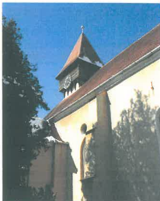
Latura sudică a navei
