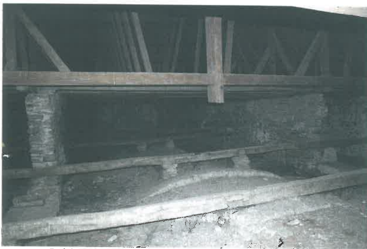
Podul navei spre vest. Cele două ziduri ale navei principale romanice.
