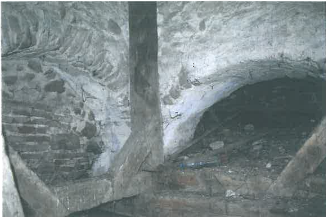
Turn, etaj: arcadele emporei romanice vestice. Se observă suprafețele de tencuieți cu zugrăveală albă pe suprafața intradosului.
