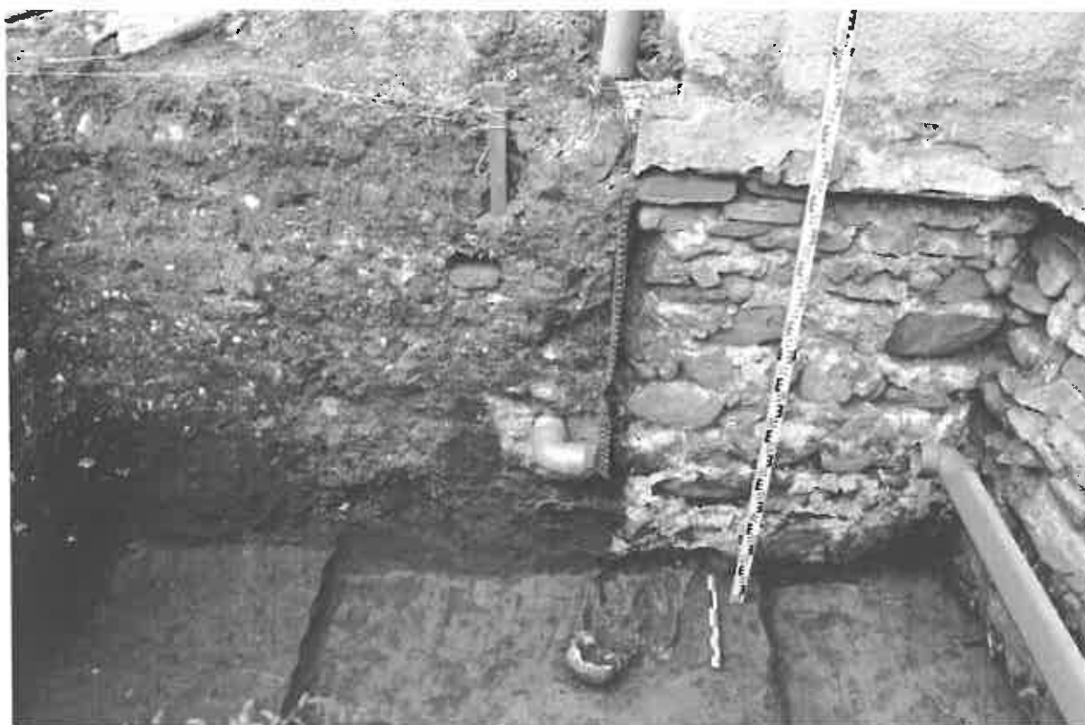
Fig. 28: Miercurea Sibiului. S 2 – M 30, fundația contrafortului, fundația colateralei de nord și profilul de est
