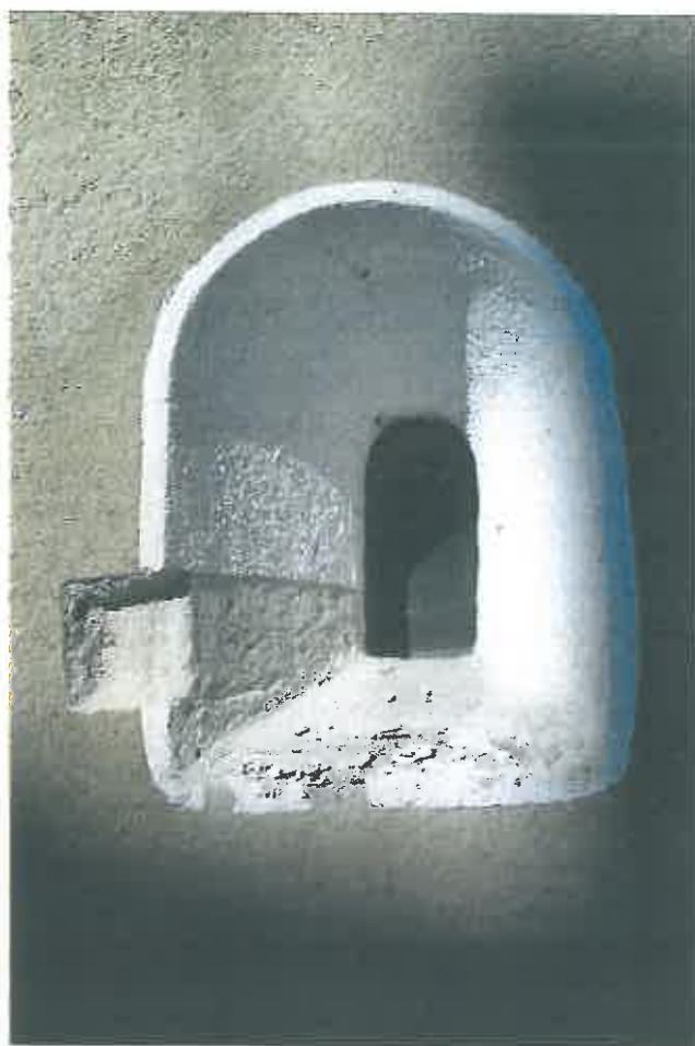
Latura sudică a navei. Fereastră romanică realizată dintr-un singur bloc de piatră
