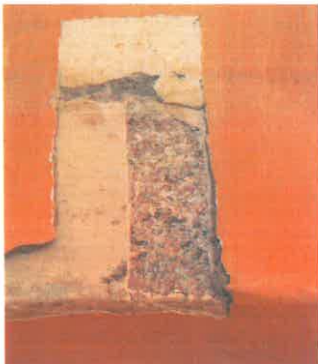
Portalul sudic. Sondaj stratigrafic pe chenarul semicircular din piatră fasonată.
