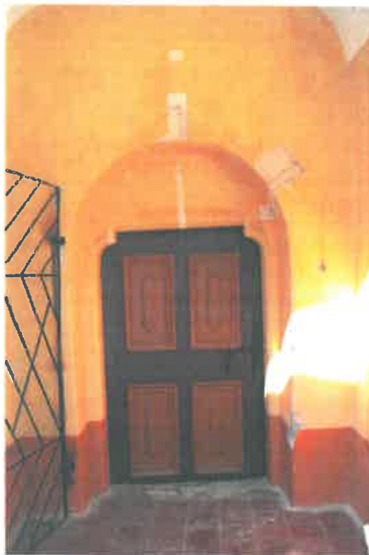
Portalul sudic. În fața portalului gotic s-a montat un chenar semicircular din piatră
