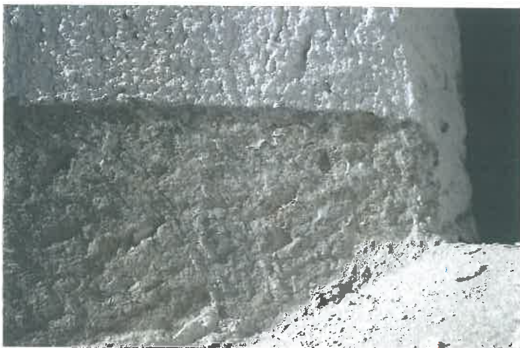
Intradosul ferestrei romanice (latura sudică a navei) În sondajul stratigrafic se observă urme de pigmenți roșii
