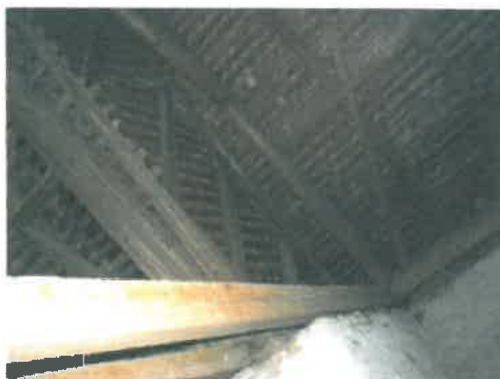
Foto nr. 44 Căprior și pop cu atac activ de insecte xilofage și halouri de umiditate
