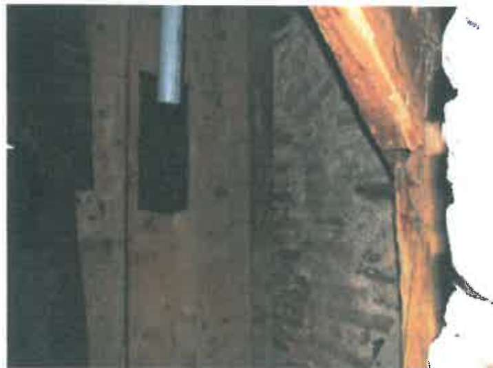
Foto nr.64 Elemente primul nivel cu atac de insecte xilofage
