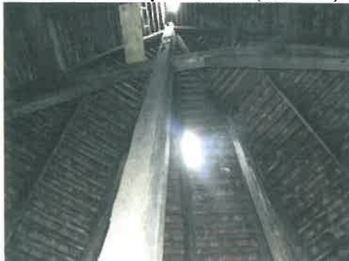
Foto nr.54 Coardă si caprior cu atac activ de insecte xilofage
