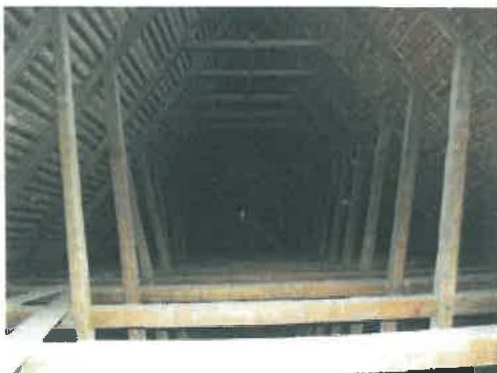
Foto nr.40 Șarpantă peste navă-vedere generală
