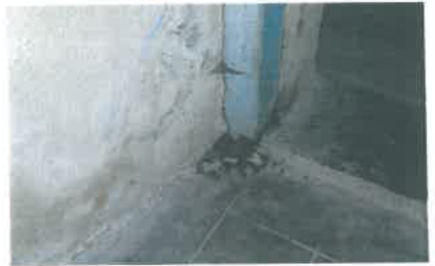
Ușa "sacristiei" Ancadramentul este degradat la partea inferioară
