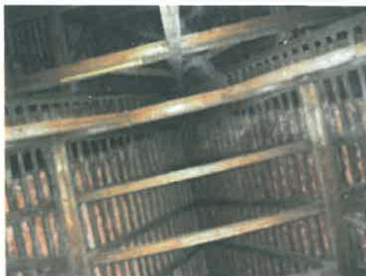
Foto nr.42 Coame cu mici halouri de umiditate
