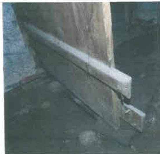
Elemente desprinse de pe canatul de uși
