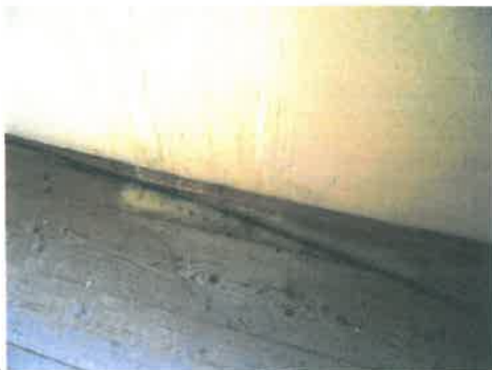
Foto nr.17 Halouri de umiditate și zone cu atac fungic la podea balcon
