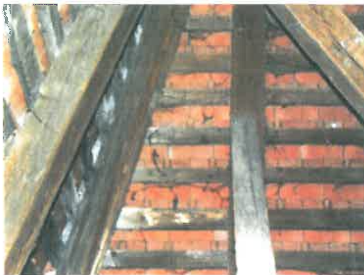
Foto nr.69 Capriori sarpanta turn-atac insecte xilofage
