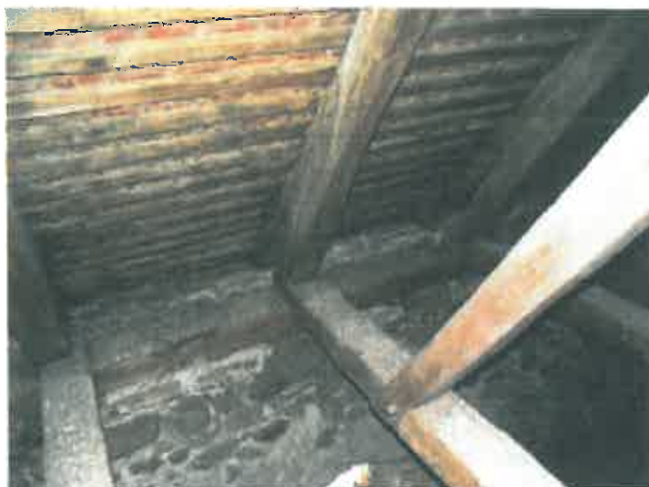
Foto nr. 49 Resturi de materiale de construcție depozitate pe cosoroabă
