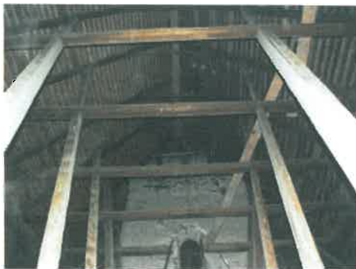
Foto nr42 Șarpantă peste navă-vedere generală
