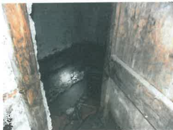
Foto nr.77 Resturi materiale de construcție depozitate în încăperi
