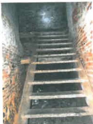
Foto nr.74 Scara acces la nivelul superior
