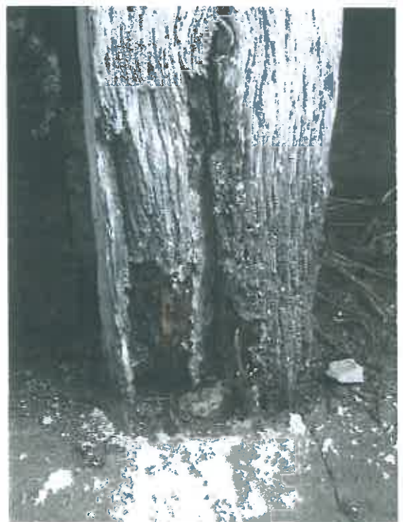
Partea inferioară degradată a stâlpilor de susținere a acoperișului zidului de apărare
