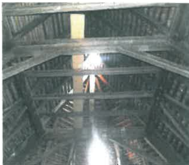
Foto nr.53 Șarpantă peste cor- lemn de stejar și de gorun
