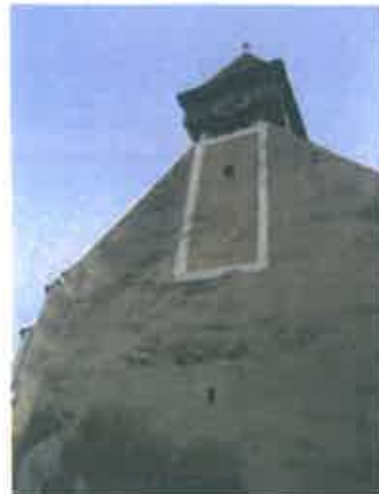
Foto nr. 59,60 Turn biserică -vedere generală
