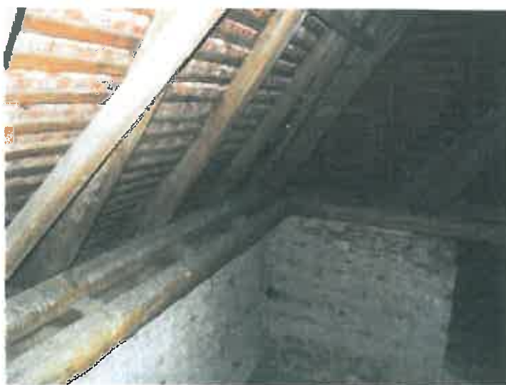
Foto nr.48 Cosoroabe in stare bună de conservare
