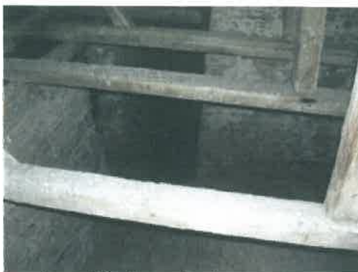
Foto nr.47 Grinzi in stare buna de conservare
