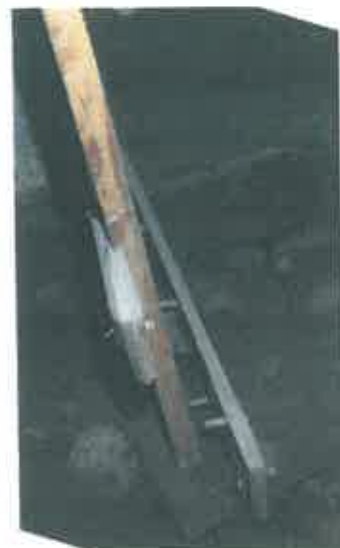
Elemente desprinse de pe canatul de uși
