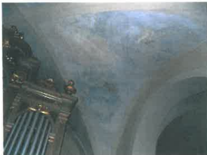
Foto nr.11 Halouri de umiditate pe tavan
