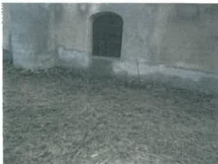
Foto nr.2 Vegetație ierboasă crescută la baza fundației.
