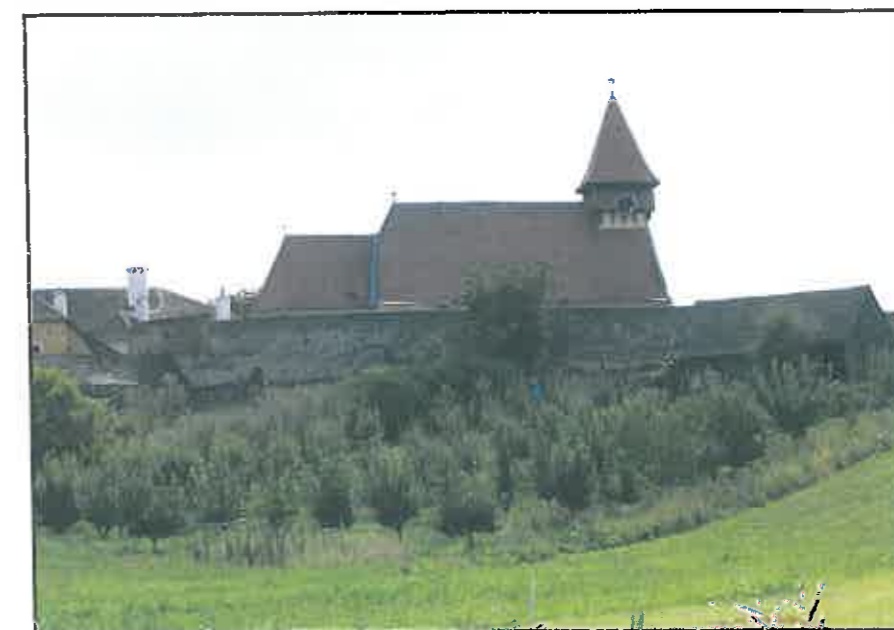
img. 14 Ansamblul bisericii fortificate - vedere nord
