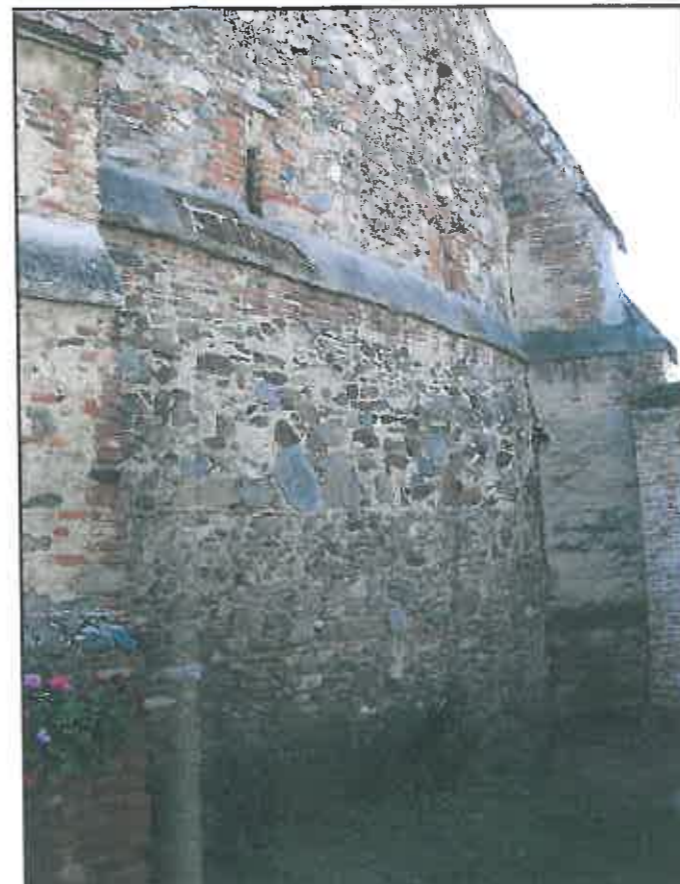
img. 71 Zidul de incintă - latura vest, vedere din exterior
