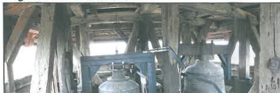
img. 44 Eșafodaj clopote la turnul de vest
