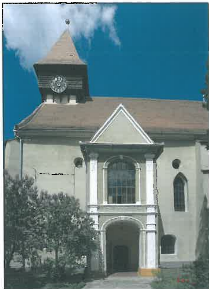
img. 15 Fațada sud cu accesul principal
