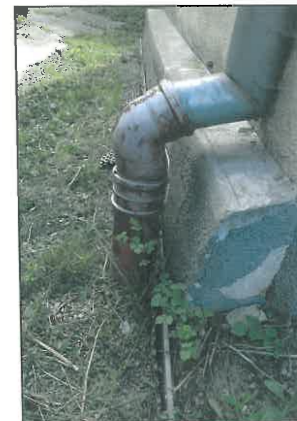
img. 26 Racord neetans între burlan și sistemul de preluare a apelor meteorice
