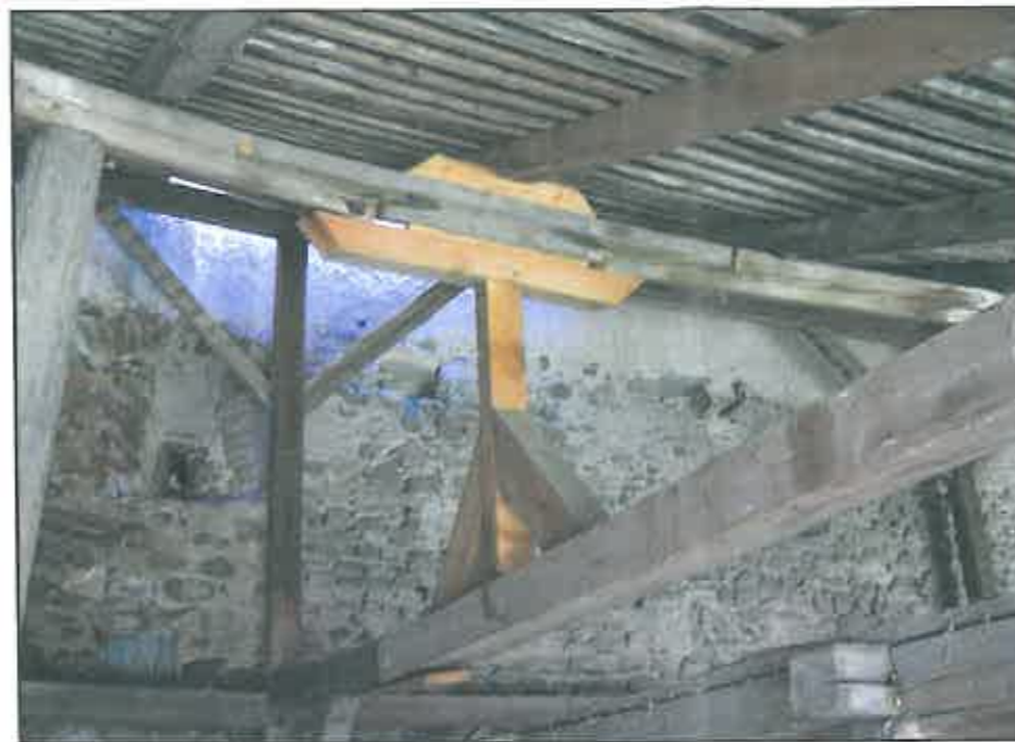
img. 65 Susțineri temporare a panei în axul 8
