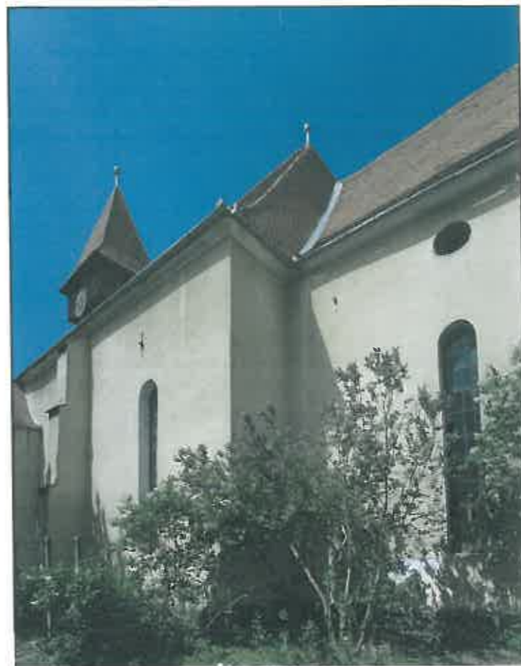
img. 16 Fațada sud
