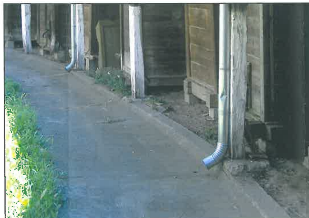
img. 80 Alee pietonală din beton adiacentă șopronului
