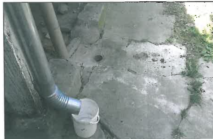
img. 77 Trotuar de beton în zona cămărilor
