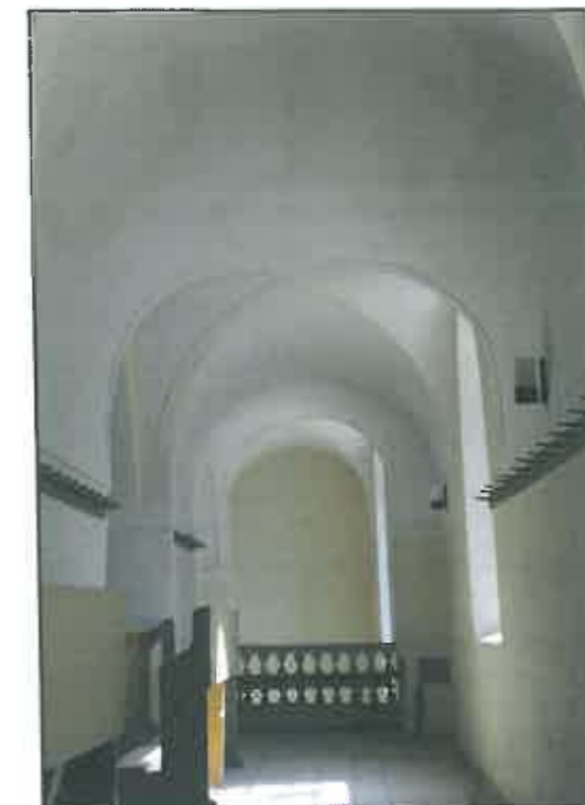
img. 29 Nava laterală sud tribune, vedere spre est
