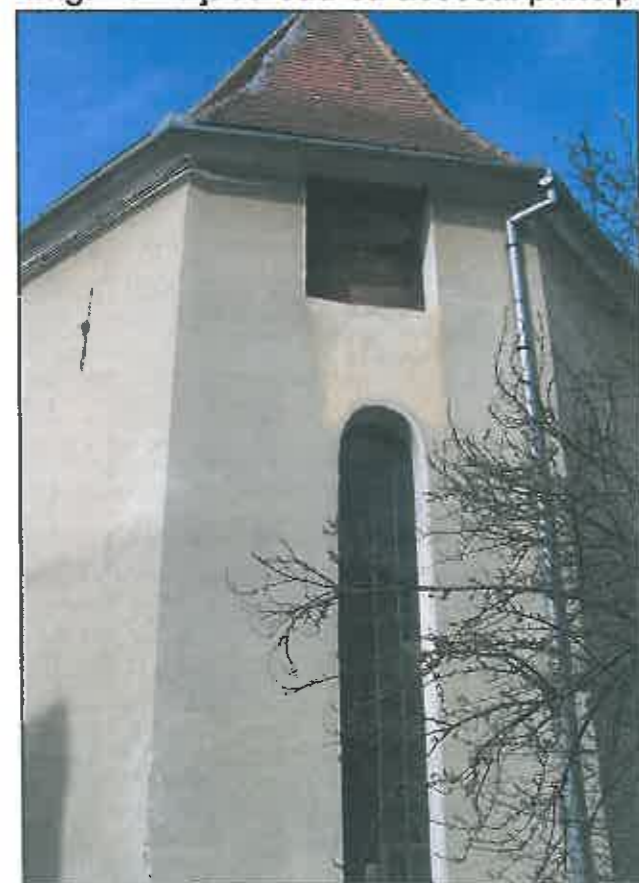
img. 18 Fațada est
