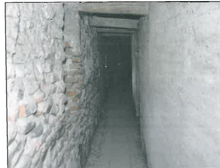
img. 60 Coridorul adiacent zidului de incintă cu accesul spre încăperile de depozitare
