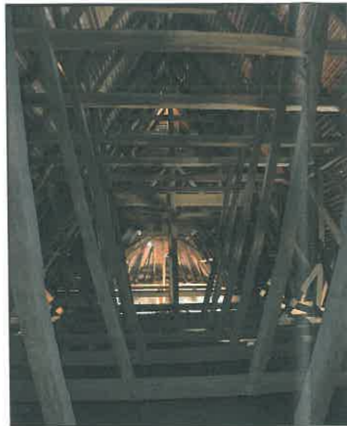
img. 39 Șarpantă navă centrală vedere spre est
