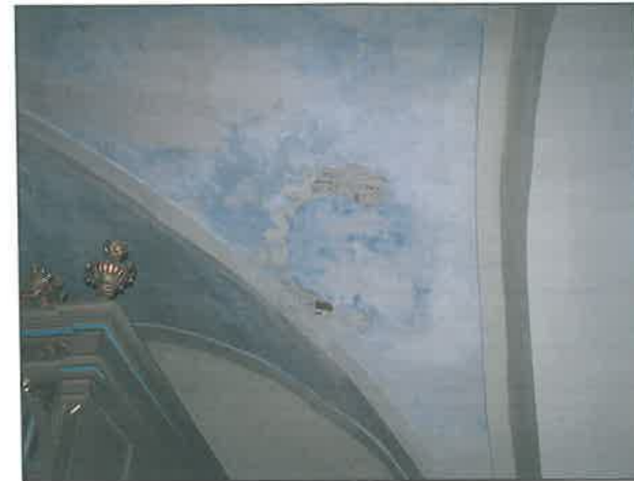
img. 37 Desprinderi locale de tencuială la bolta tribunei din partea de vest
