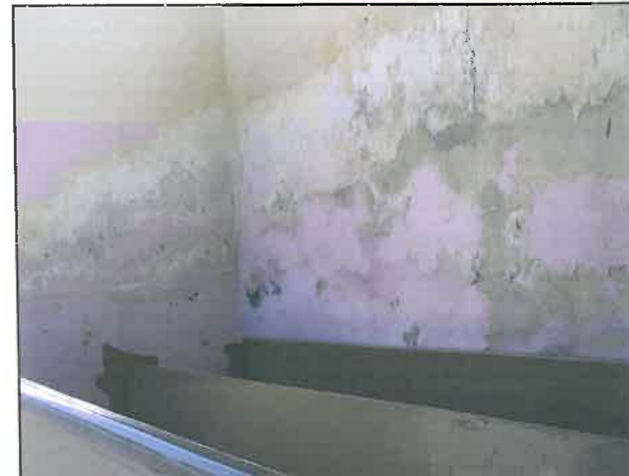
img. 34 Umiditate prezentă la peretele navei laterale sud
