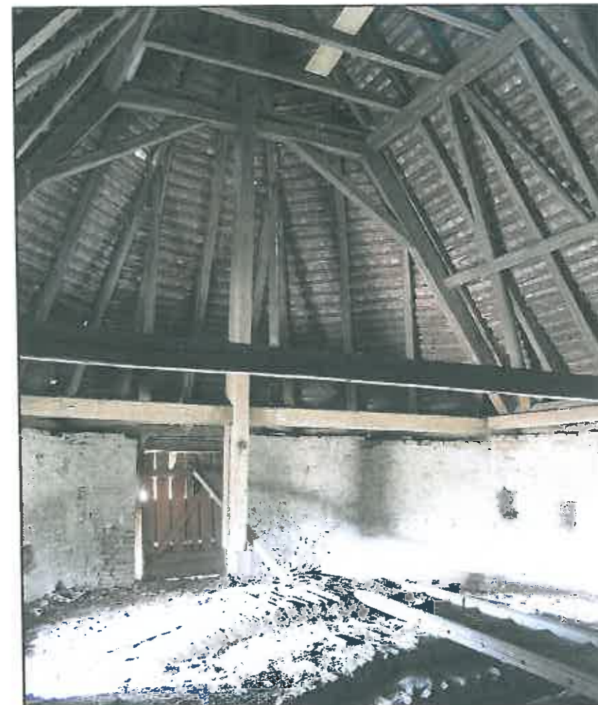
img. 40 Șarpantă cor
