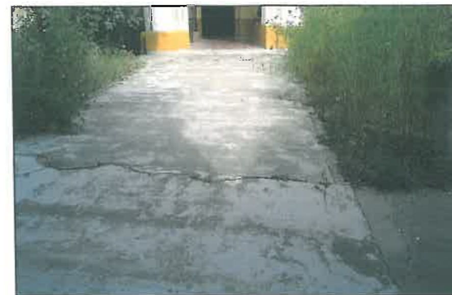
img. 78 Trotuar din beton la accesul principal în biserică, latura sud
