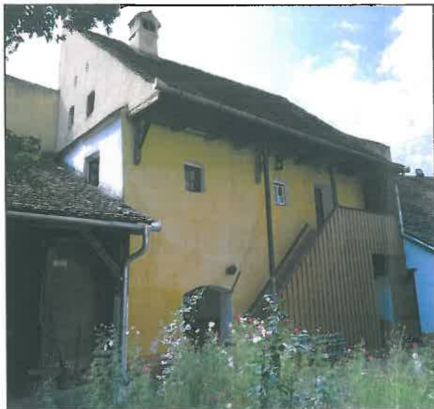
img. 51 Turnul de poartă vedere din interior
