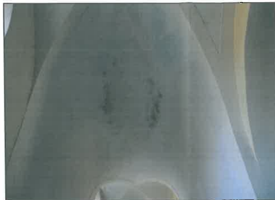
img. 33 Halou de umiditate la bolta navei laterale sud
