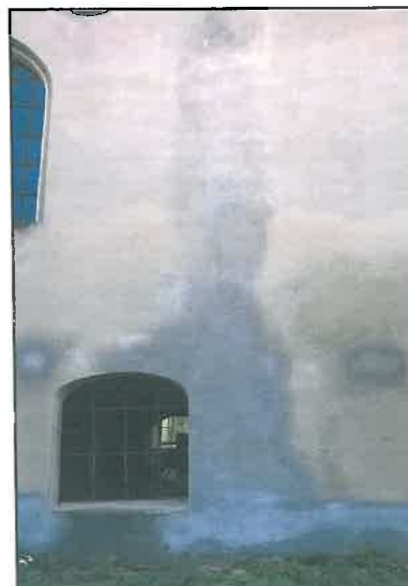
img. 24 Intervenții recente la tencuieli cu mortar de ciment
