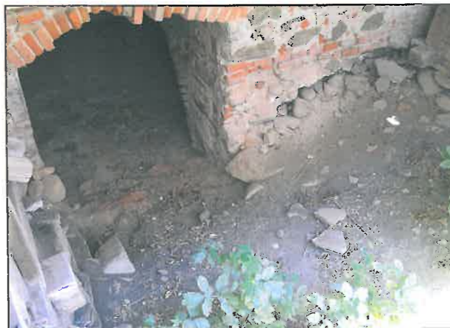
img. 62 Degradări prin dislocarea zidului de sprijin adiacent accesului spre pivnițe
