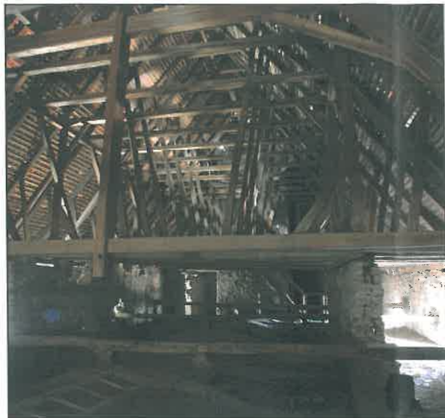
img. 38 Șarpantă nava centrală vedere spre vest
