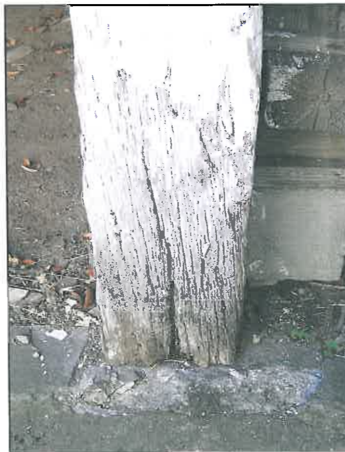
img. 68 Degradări locale la baza stâlpilor de susținere a acoperișului
