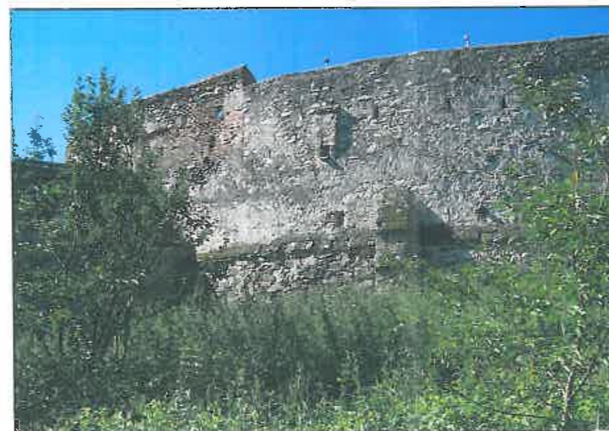
img. 74 Zidul de incintă - latura nord vest, vedere din exterior
