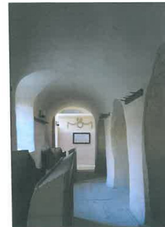
img. 31 Nava laterală nord parter, vedere spre est
