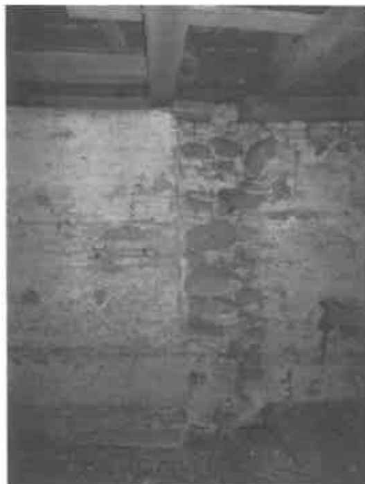
Fig. 7. Zidărie din faze diferite de construcție pod, perete sudic
