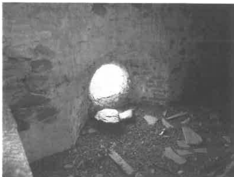
Fig. 5. Urme ale ferestrelor gotice la fereastra circulară din pod
