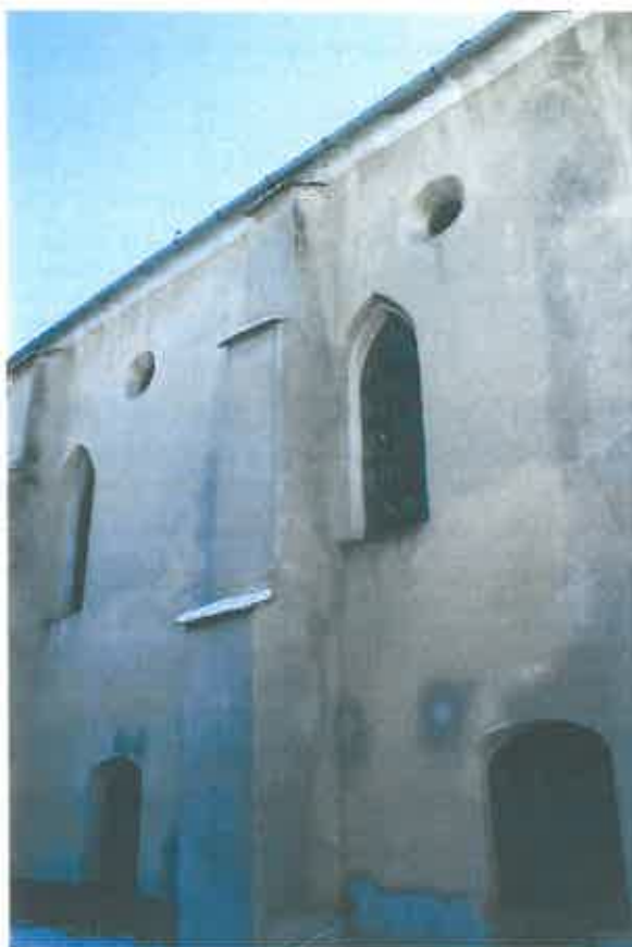
Latura nordică a navei
