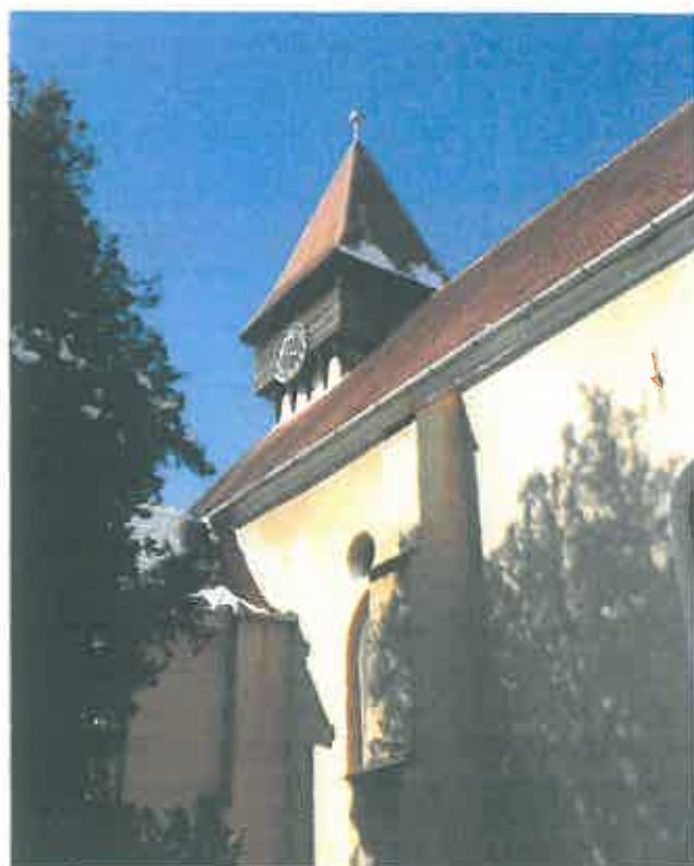
Latura sudică a navei
