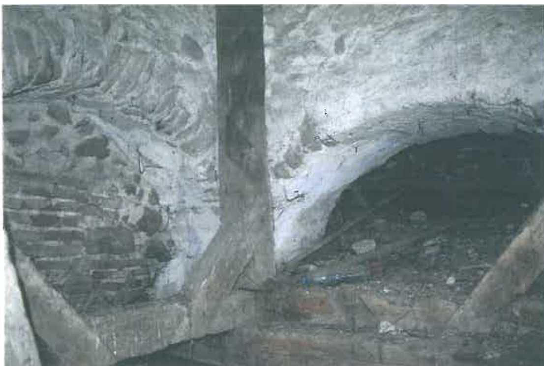
Turn, etaj: arcadele emporei romanice vestice. Se observă suprafețele de tencuieli cu zugrăveală albă pe suprafața intradosului.
