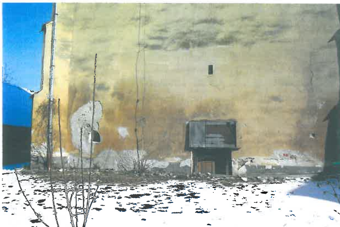
Fațada vestică. În zona inferioară se observă o căptușeală a zidului cu țigle și mortar de ciment
