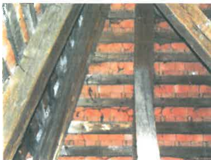
Foto nr.69 Capriori sarpanta turn-atac insecte xilofage
