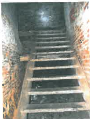
Foto nr.74 Scara acces la nivelul superior
