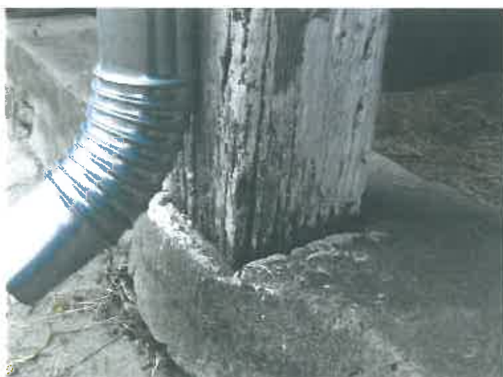
Partea inferioară degradată a stâlpilor de susținere a acoperișului zidului de apărare
