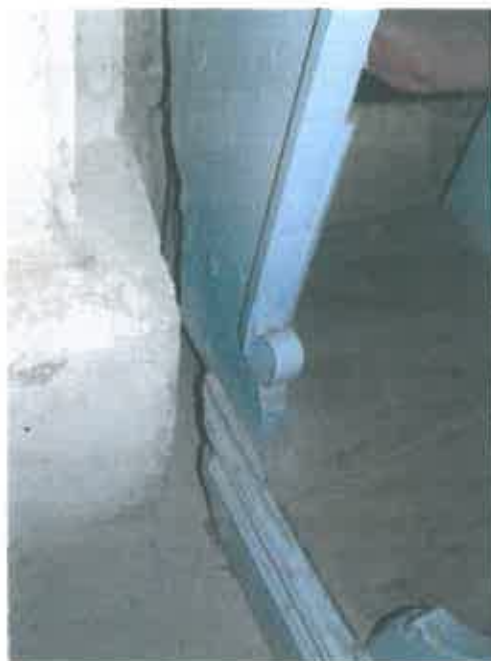
Grinzile de talpă ale stranelor sunt degradate
