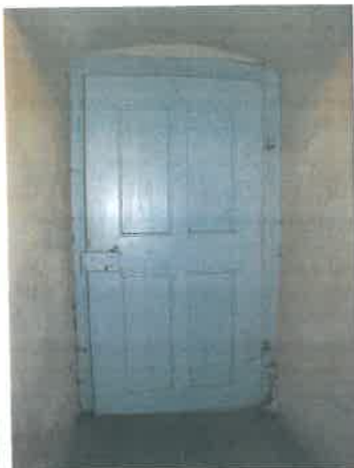
Ușa "sacristiei" Ancadramentul este degradat la partea inferioară
