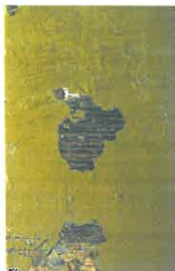
Detaliu cu desprinderea stratului de revopsire pe băncile din nava centrală, unde se observă un strat de pictură mai vechi, tip floder
