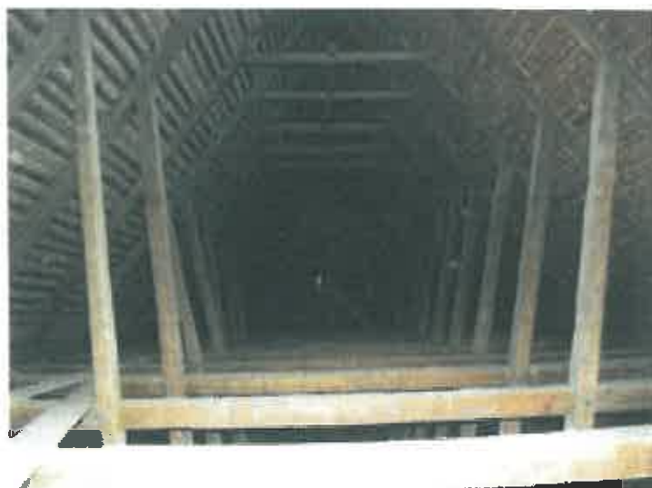
Foto nr.40 Șarpantă peste navă-vedere generală
