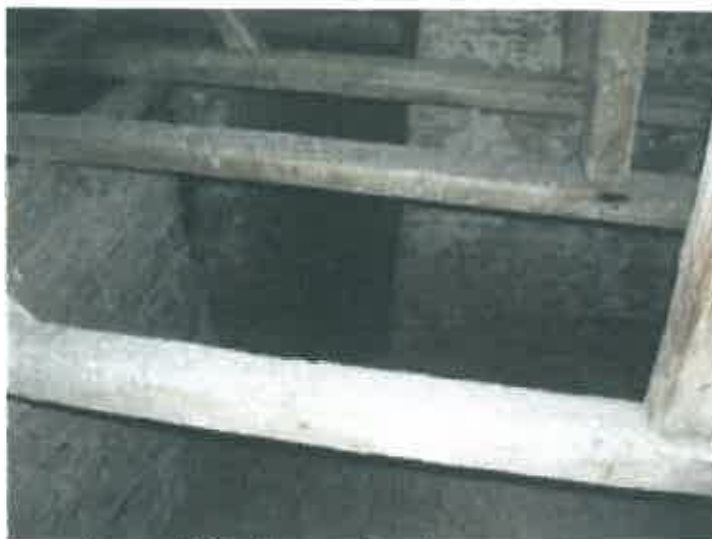
Foto nr.47 Grinzi în stare buna de conservare
