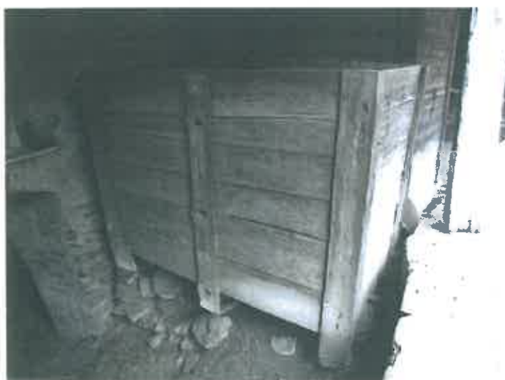
Ladă construită prin tehnici dulgherești, din lemn de fag, prelucrat prin cioplire
