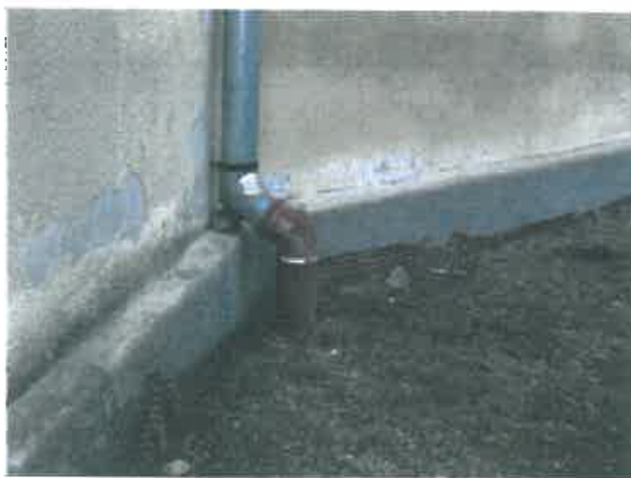
Foto nr.4 Izolație orizontală
