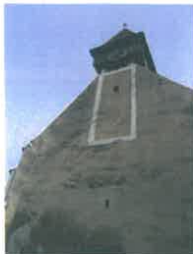
Foto nr. 59,60 Turn biserică -vedere generală
