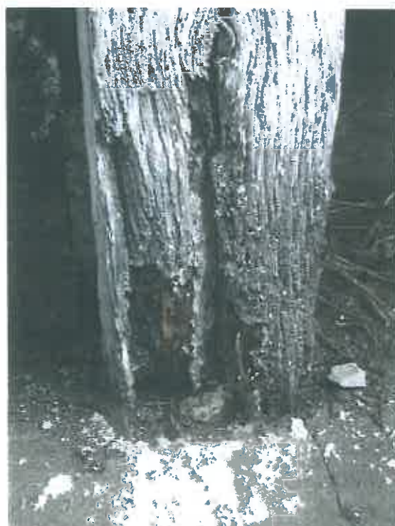
Partea inferioară degradată a stâlpilor de susținere a acoperișului zidului de apărare
