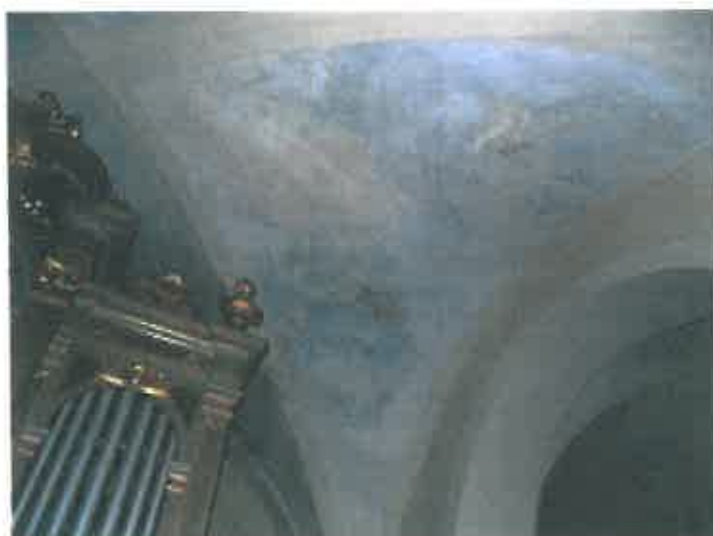
Foto nr.11 Halouri de umiditate pe tavan
