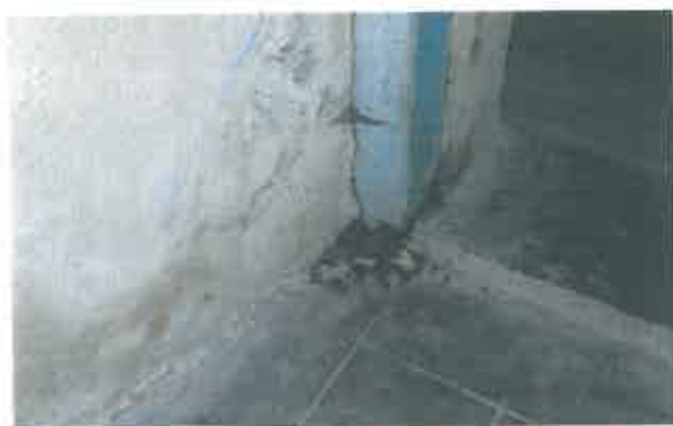
Ușa "sacristiei" Ancadramentul este degradat la partea inferioară
