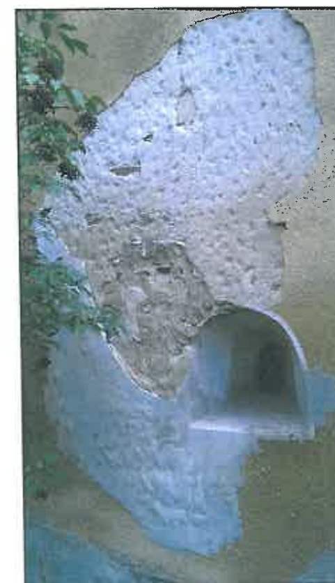
img. 25 Desprinderi locale a tencuielilor la fațada vest
