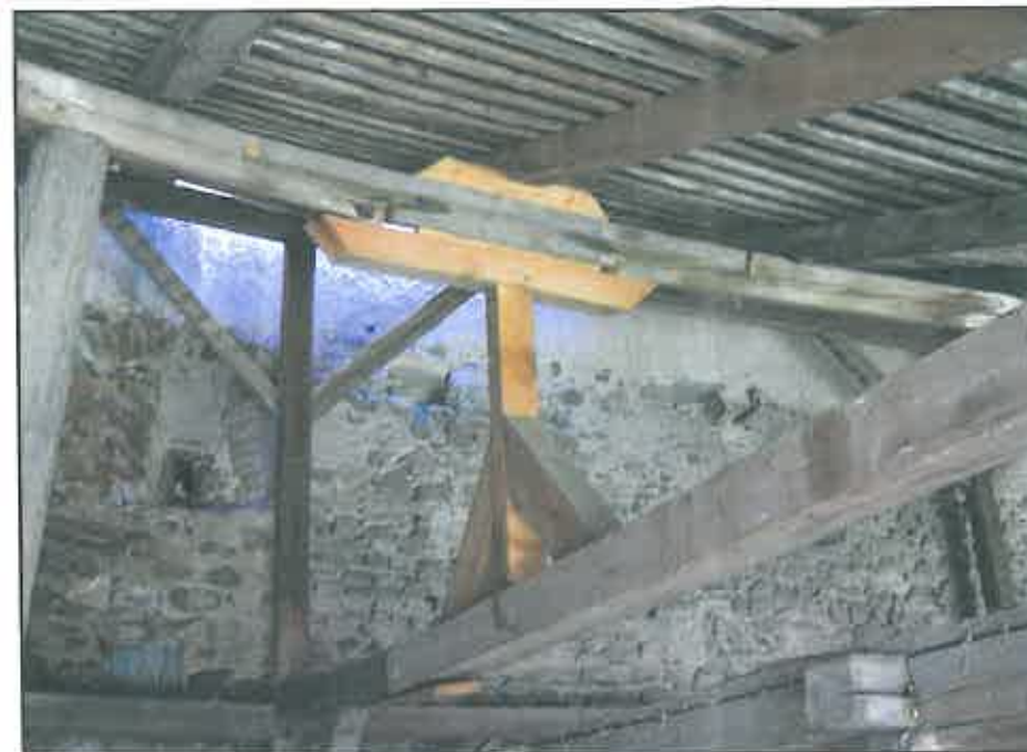
img. 65 Susțineri temporare a panei în axul 8
