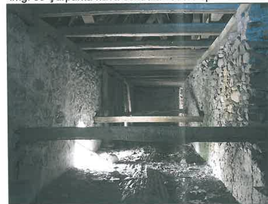
img. 42 Pod nava laterală sud (este vizibil sistemul de susținere a grinzilor la peretele exterior între axele 1-9)
