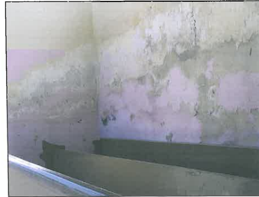
img. 34 Umiditate prezentă la peretele navei laterale sud
