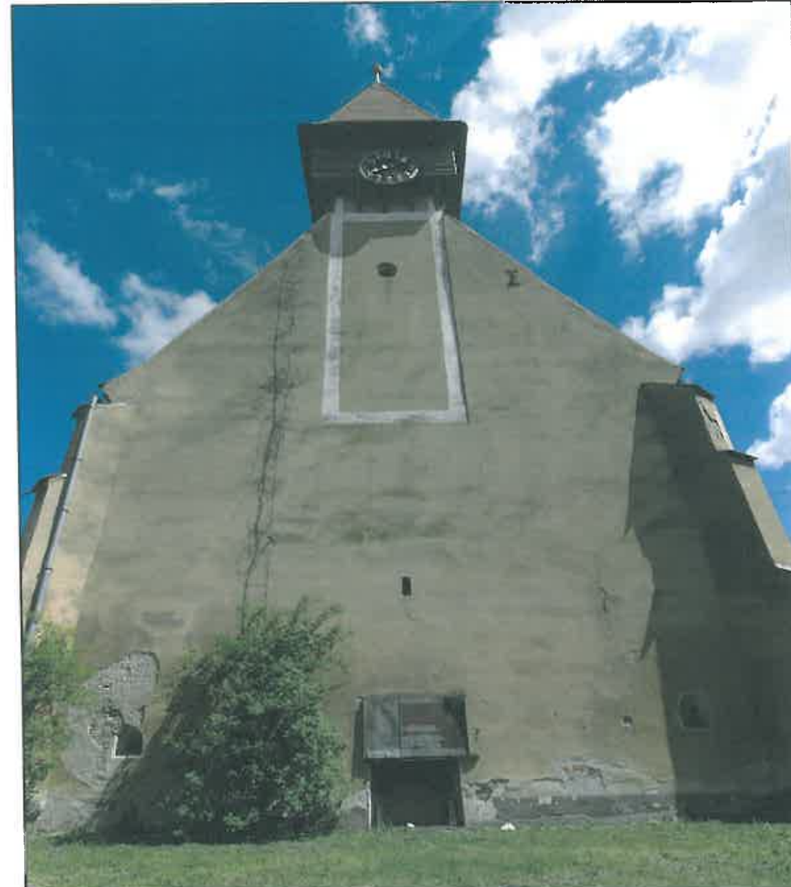
img. 17 Façada vest
