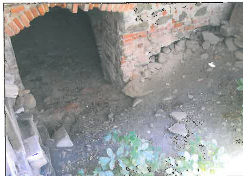
img. 62 Degradări prin dislocarea zidului de sprijin adjacent accesului spre pivnițe
