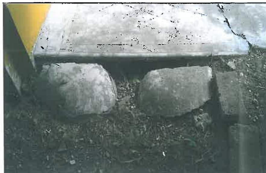
img. 76 Rigolă colmatată sub placa de beton în dreptul accesului sud în biserică
