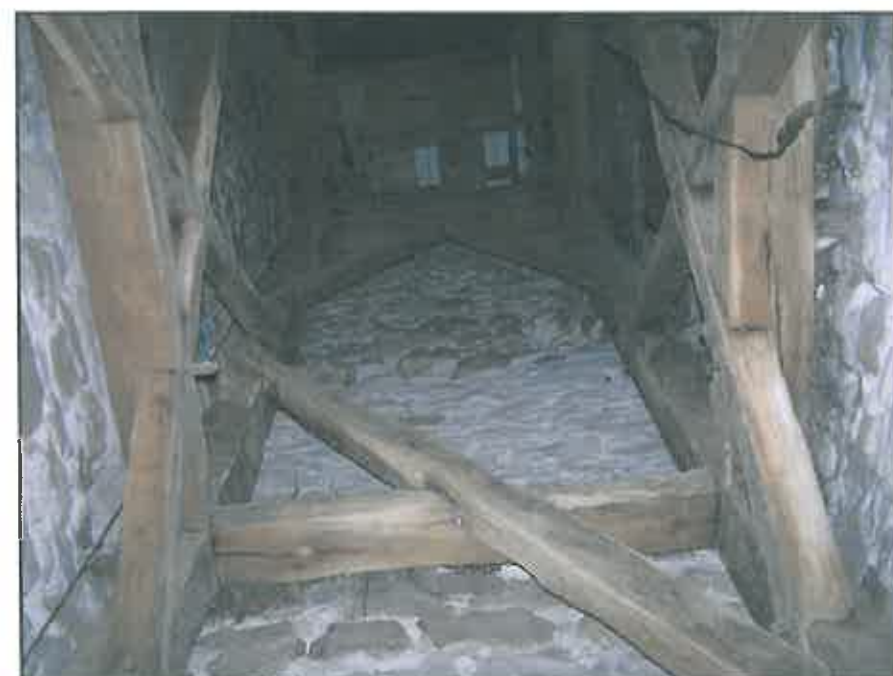
img. 48 Degradări prin elemente lipsă sau dislocate la structura spațială în interiorul turnului de vest
