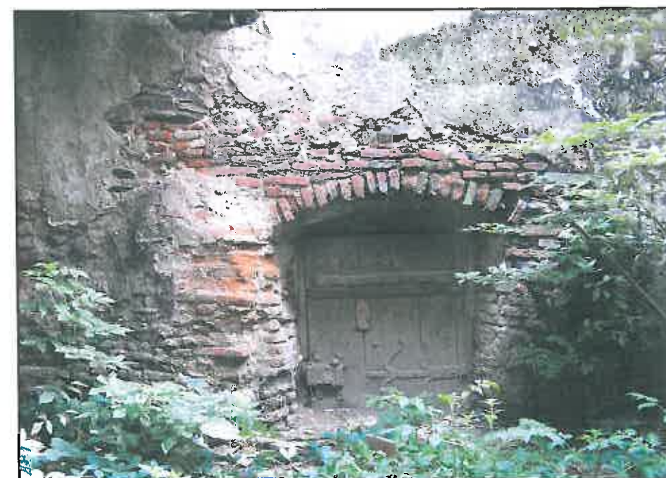
img. 55 Curtea interioară colmatată de moloz și vegetație parazitară. Este vizibilă poarta spre piață (zidită la exterior).
