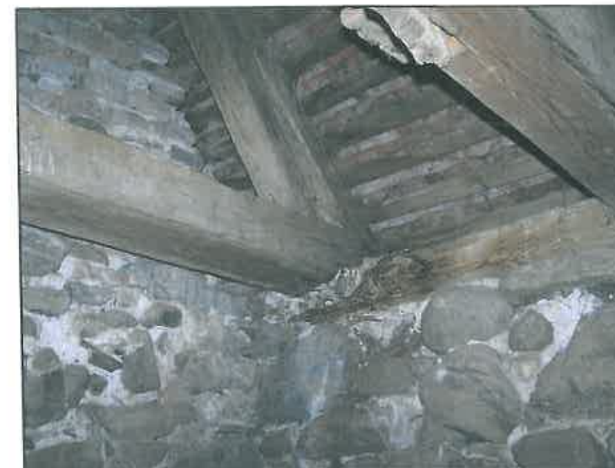
img. 47 Cosoroabă degradată la șarpanta navei laterale nord
