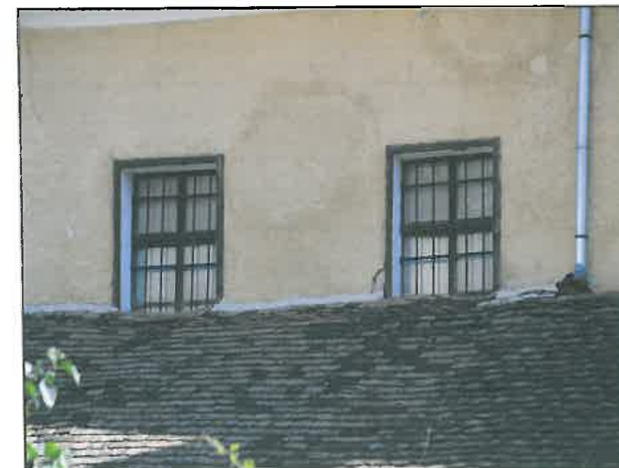
img. 69 Zonă neetanșă pentru apele meteorice în dreptul ferestrelor casei parohiale și acoperișul șopronului
