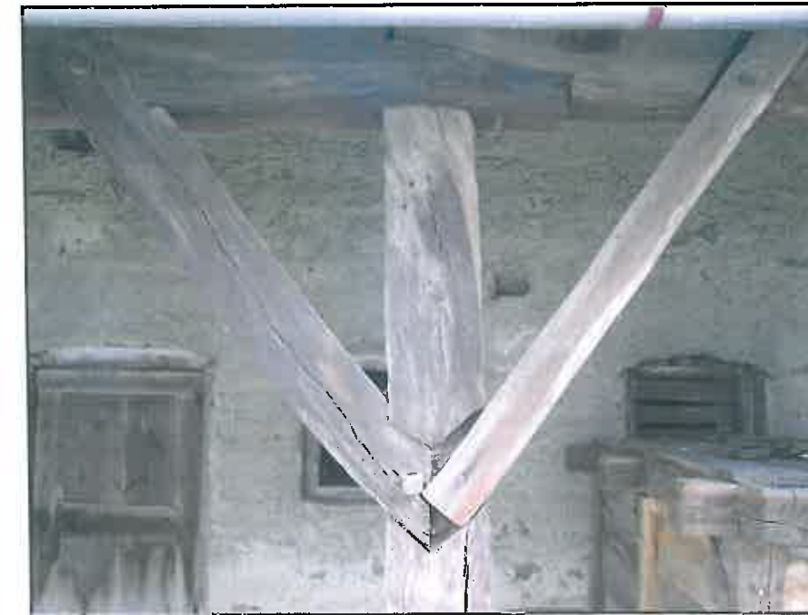
img. 63 Reparații neadecvate la nivelul îmbinărilor elementelor structurale din lemn
