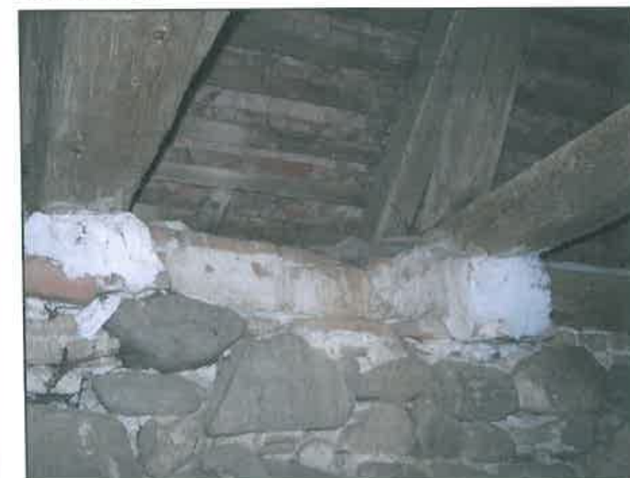
img. 50 Cosoroabă întreruptă la șarpanta navei laterale nord
