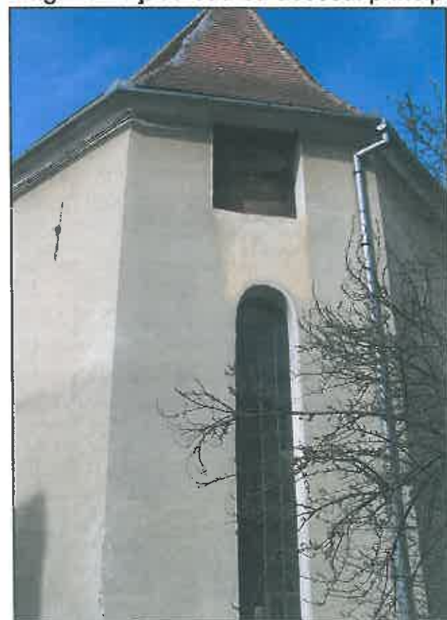
img. 18 Façada est
