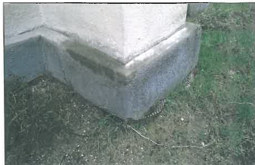
img. 20 Soclu din beton protejat de folie amprentată la fațada spre sud și spre est
