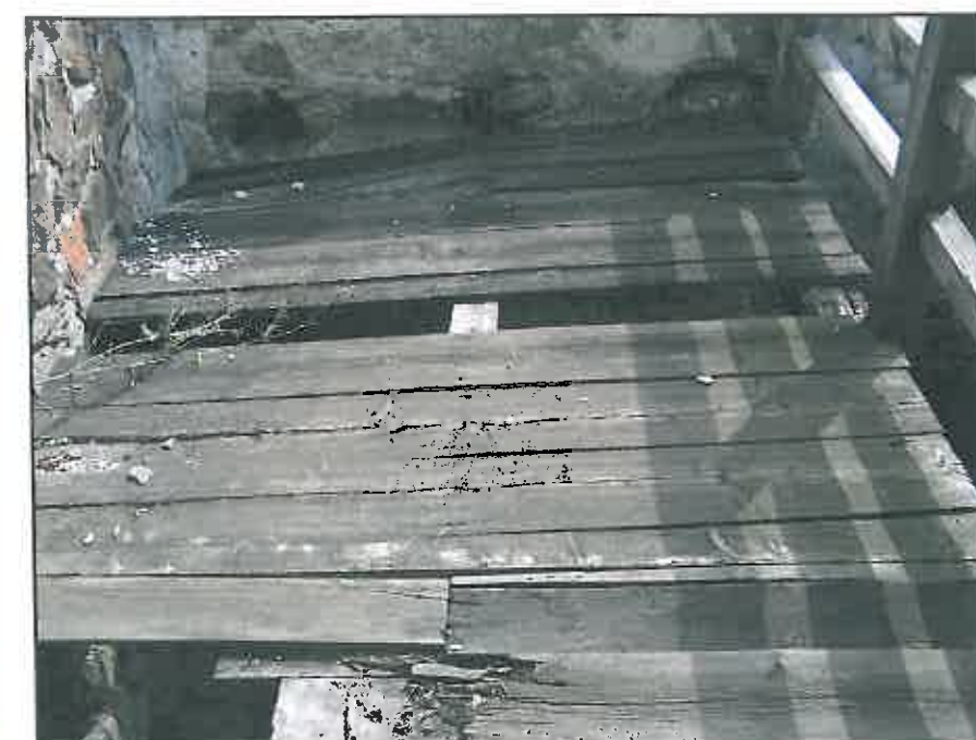
img. 56 Degradări la pardoseala terasei de la nivelul 1
