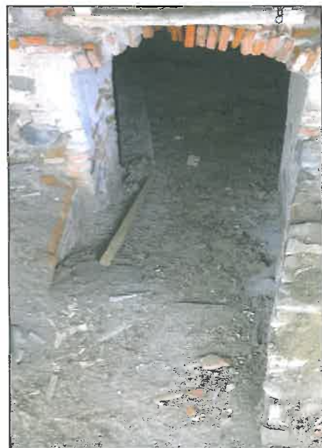
img. 61 Degradări locale ale arcelor și bolților din cărămidă la spațiile de depozitare la nivelul pivnițelor
