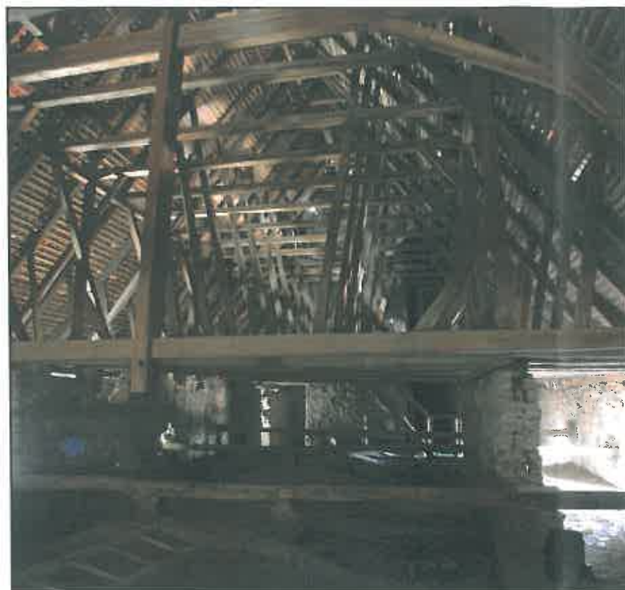
img. 38 Șarpantă nava centrală vedere spre vest
