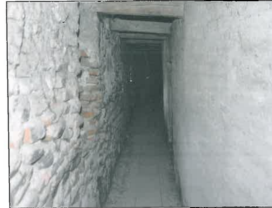
img. 60 Coridorul adjacent zidului de incintă cu accesul spre încăperile de depozitare
