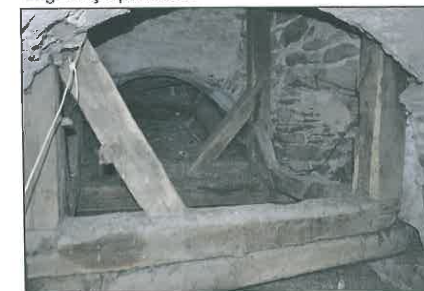
img. 43 Nivel 1 - turnul de vest Lucrări de reparații, conservare și introducere în circuitul turistic la Ansamblul bisericii evanghelice fortificate din Miercurea Sibului
