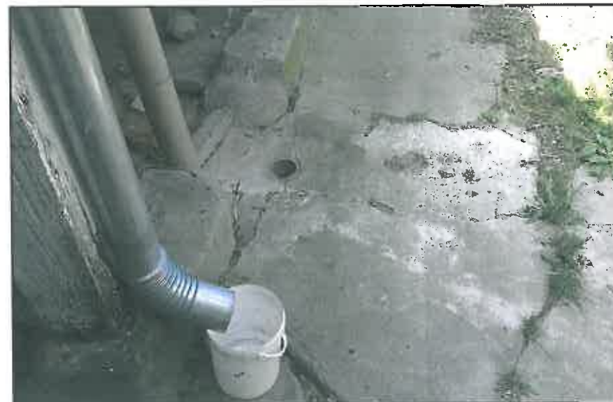
img. 77 Trotuar de beton în zona cămărilor
