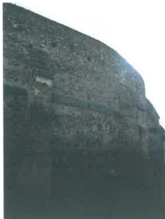
Fig. 13. Zid de incintă, parte vestică
