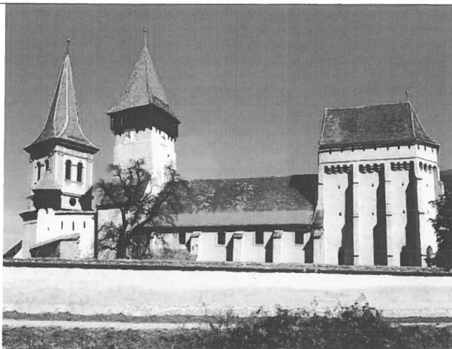
Fig. 1. Șeica Mică - vedere dinspre sud
