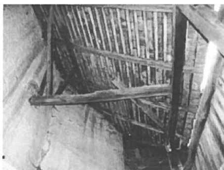
Foto nr. 152 Șarpantă drum de strajă
