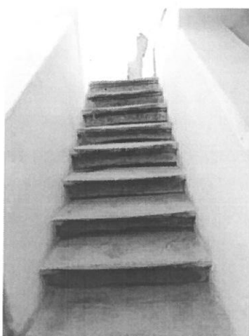
Foto nr.36 Scară de acces în galerie laterală
