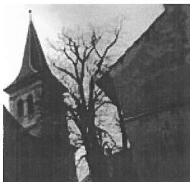
Foto nr.118 Turn de vest-vedere general
