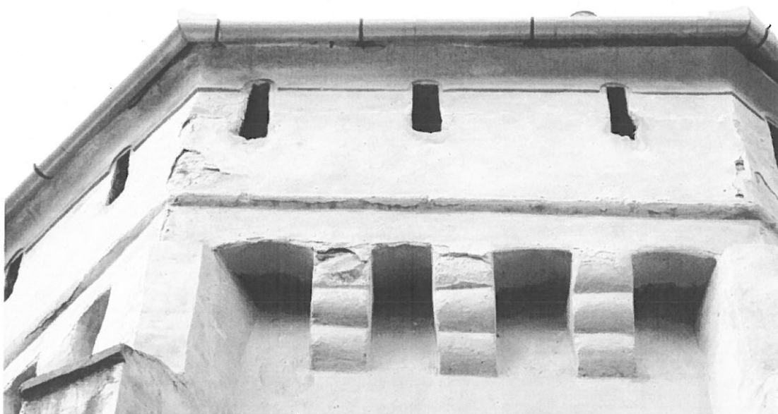
Latura estică a altarului, etajul III cu gurile de smoală. Consolele etajului III sunt sprijinite pe blocuri de piatră.
