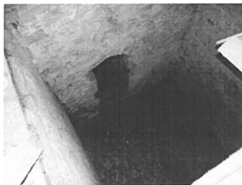
Foto nr.98 Primul nivel-zidărie
