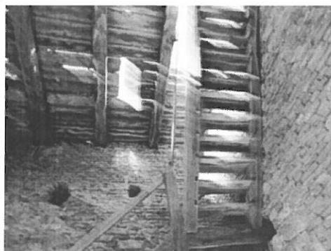
Foto nr. 125 Scara de acces in nivel II
