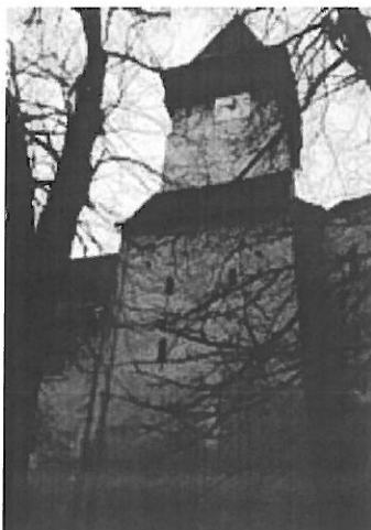
Foto nr. 94 Turn biserică -vedere generală
