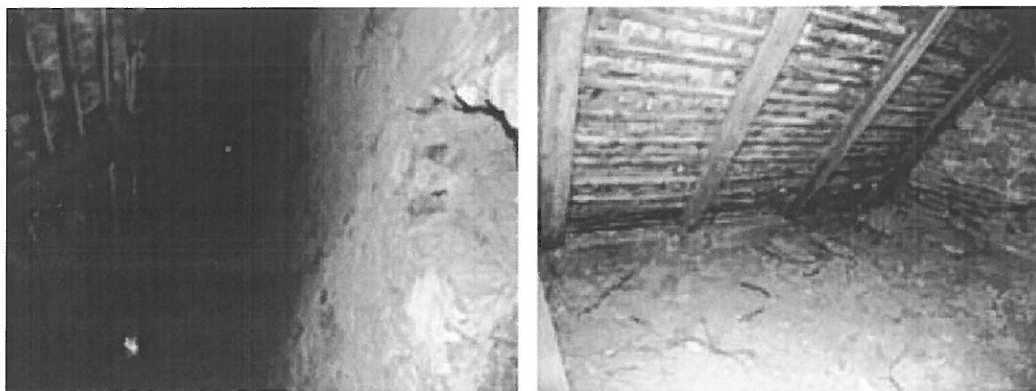
Foto nr.104,105 Șarpantă adiacentă de nord
