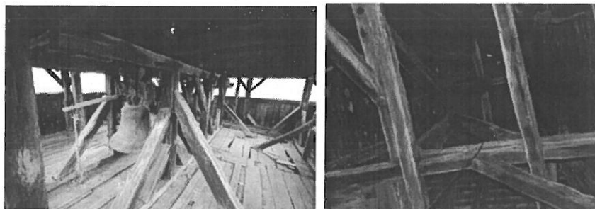
Fig. 16. Coridorul de apărare, cel de-al cincilea nivel al turnului clopotniță (Westurm, germ.), cu clopotul de doliu datat "1556", șarpanta
