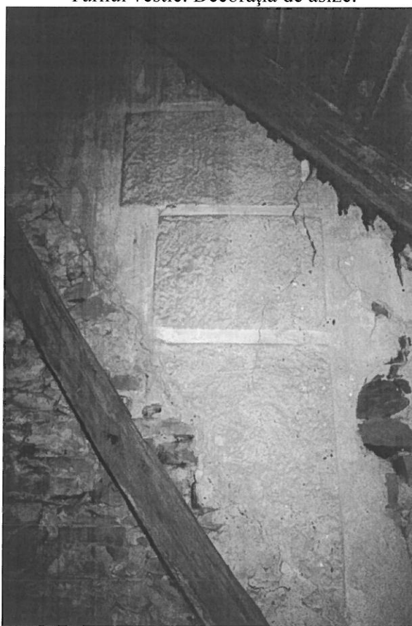
Latura estică a turnului, zona podului. Decorația de asize, și urma inprimată a șarpantei anterioare
