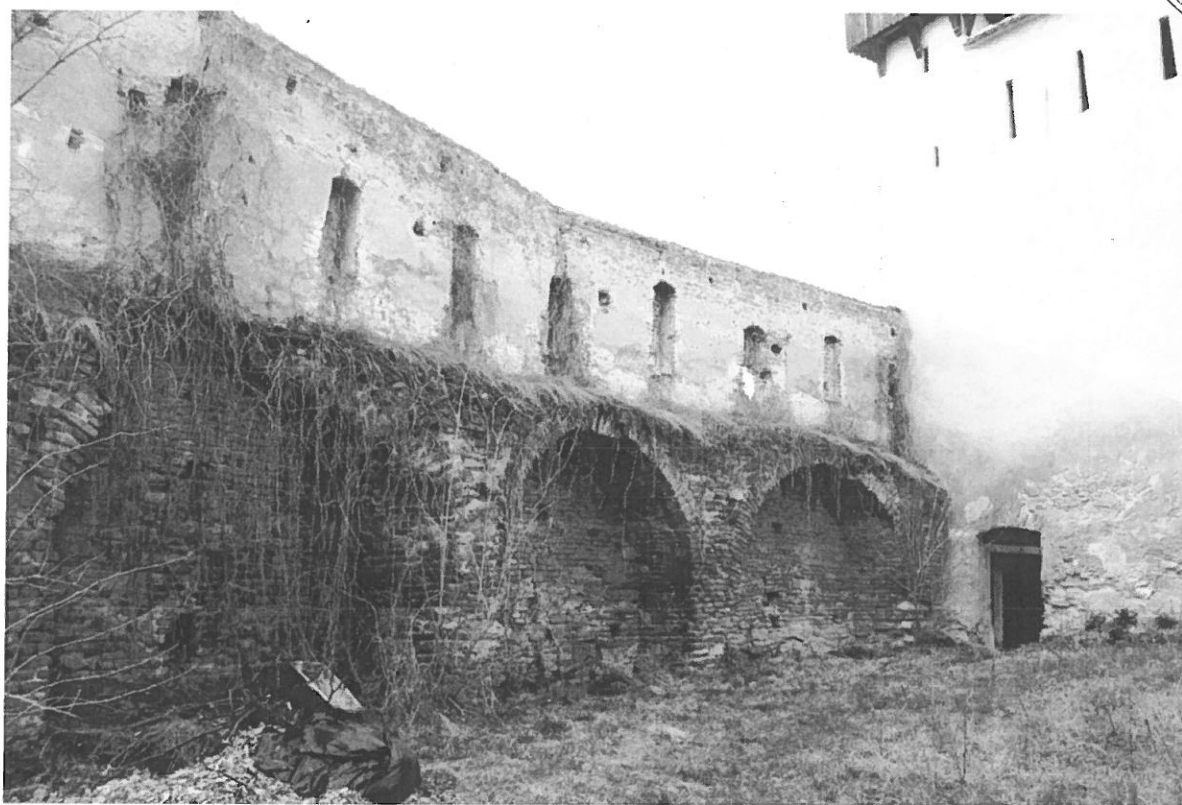
Fragment din zidul de incintă interior (latura sud-vestică)
