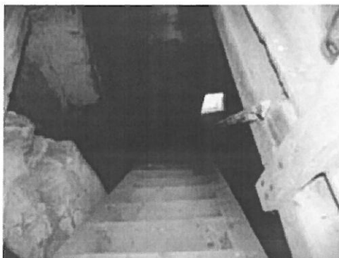
Foto nr.100 Scară de acces în nivel trei
