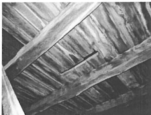
Foto nr.126 Nivel II turn
