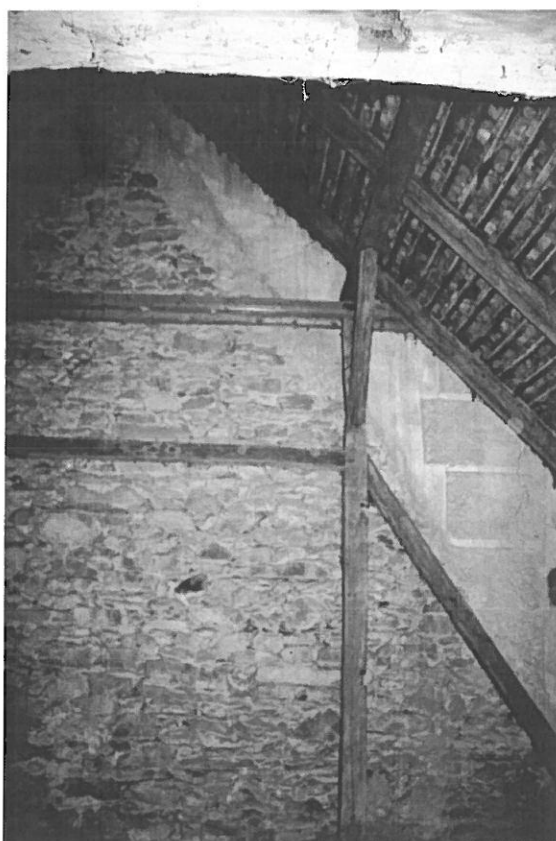
Latura estică a turnului, zona podului. Urma imprimată a șarpantei anterioare
