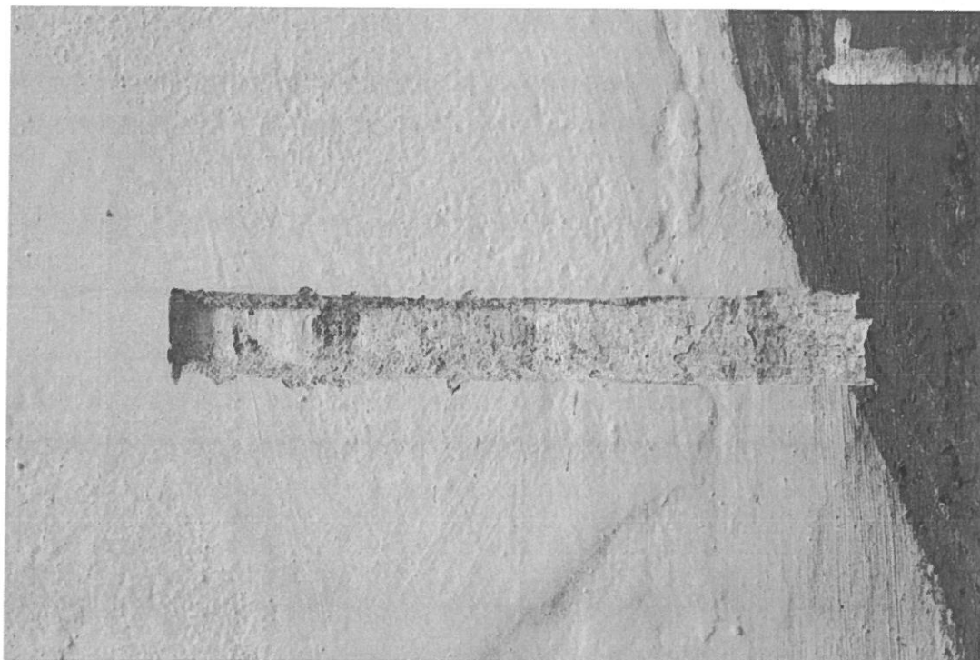
Sondaj stratigrafic pe suprafața peretelui estic al navei laterale nordice.
