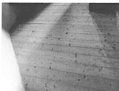
Foto nr.42 Pardoseală confecționată din scânduri de brad.
