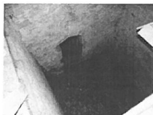
Fig. 15. Vedere spre nivelul I al turnului clopotniță
