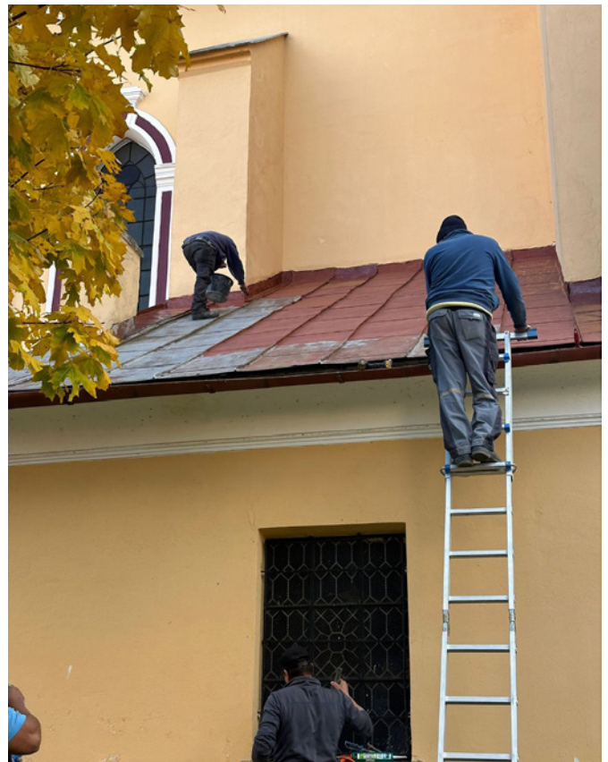
In Heldsdorf fand das vierte Arbeitscamp statt und diesmal ging es vor allem um die Dachreparatur im Predigerhof.
