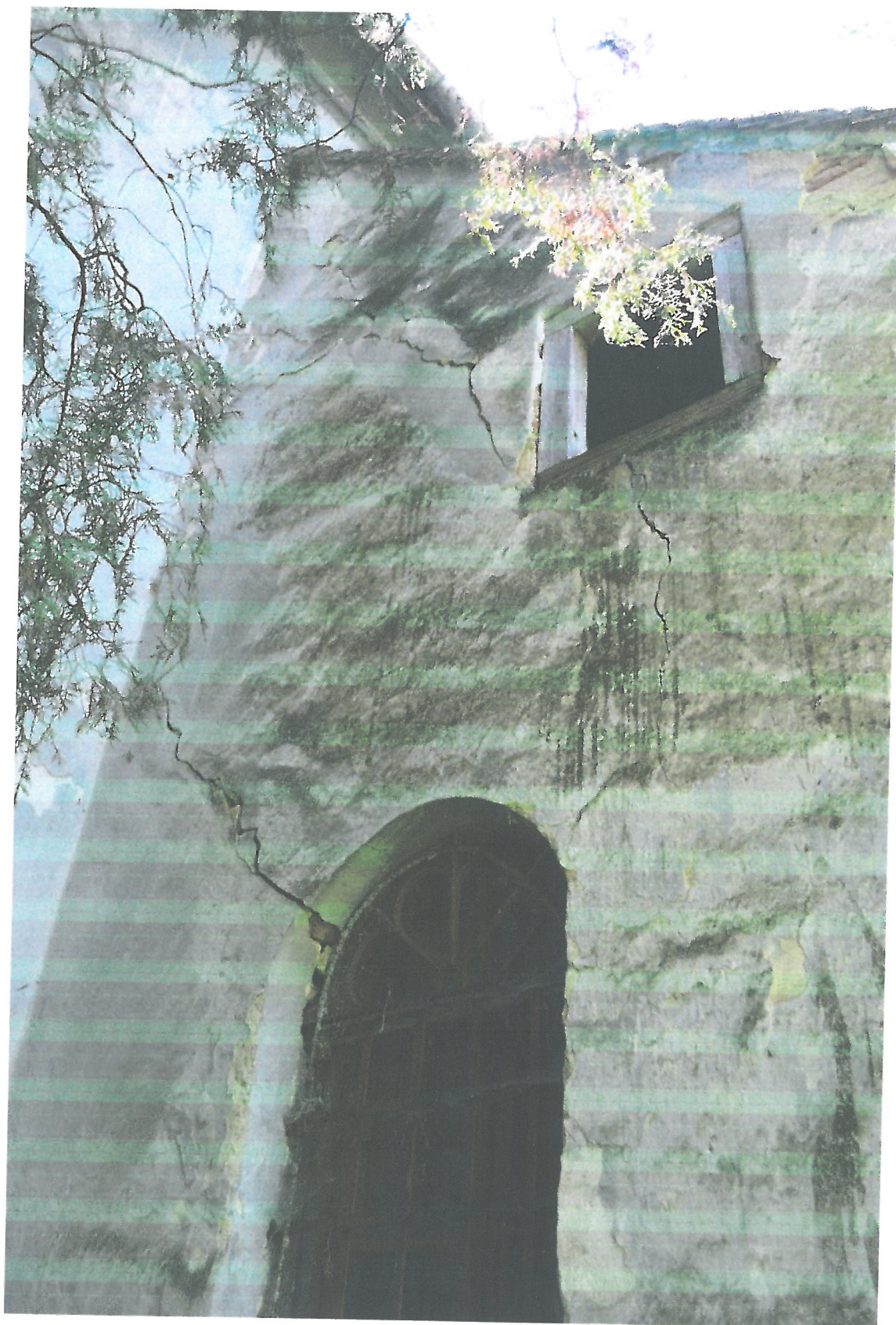
Foto 12 – Crapaturi diagonale datorate tasarilor diferite ale terenului de fundare
