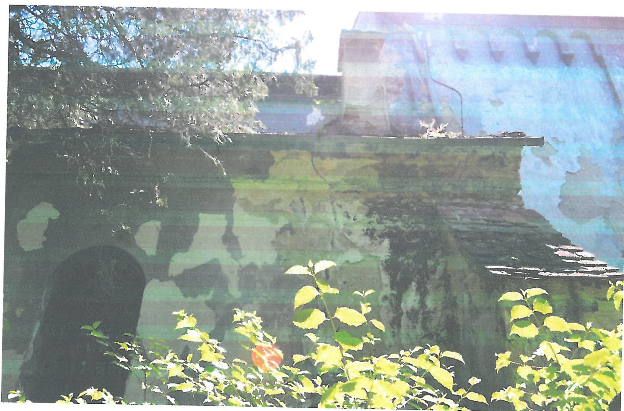
Foto 11 – Tencuieli degradate si zidarie macinata la anexa altarului
