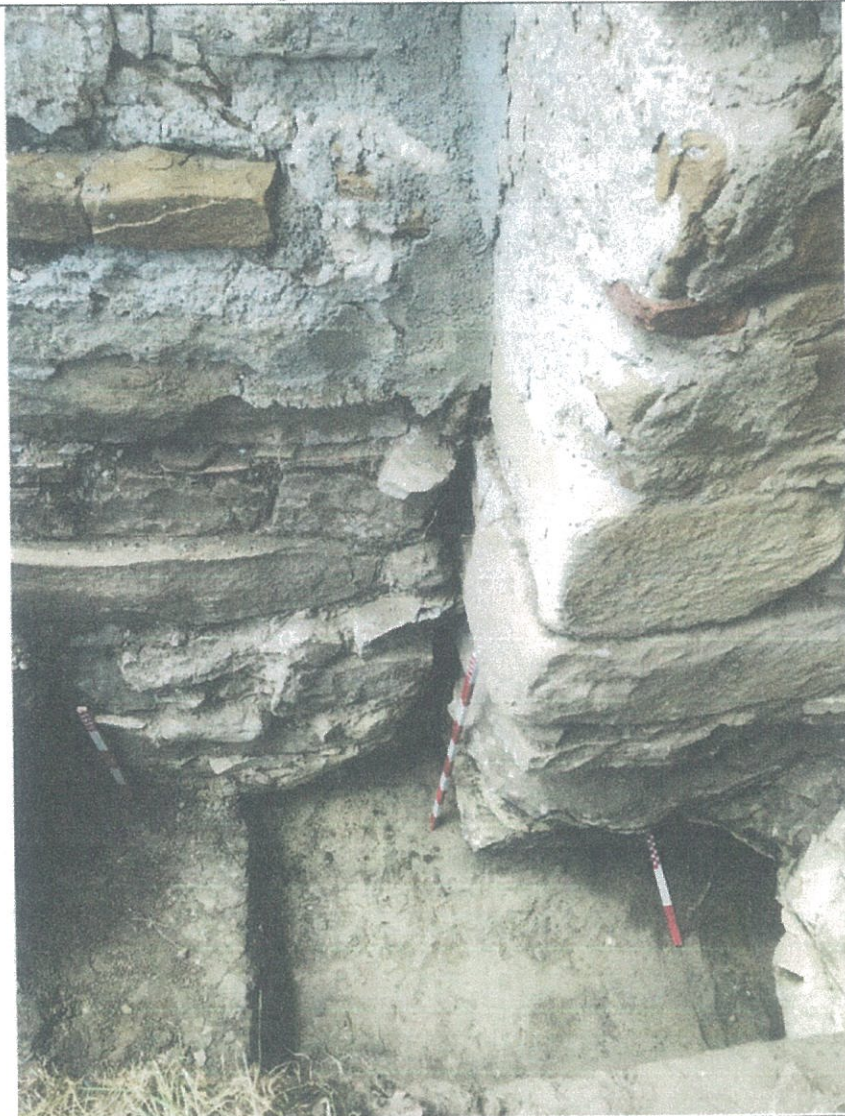
Fig. 11. C2 - detaliu privind fundația contrafortului adosat pe nava
