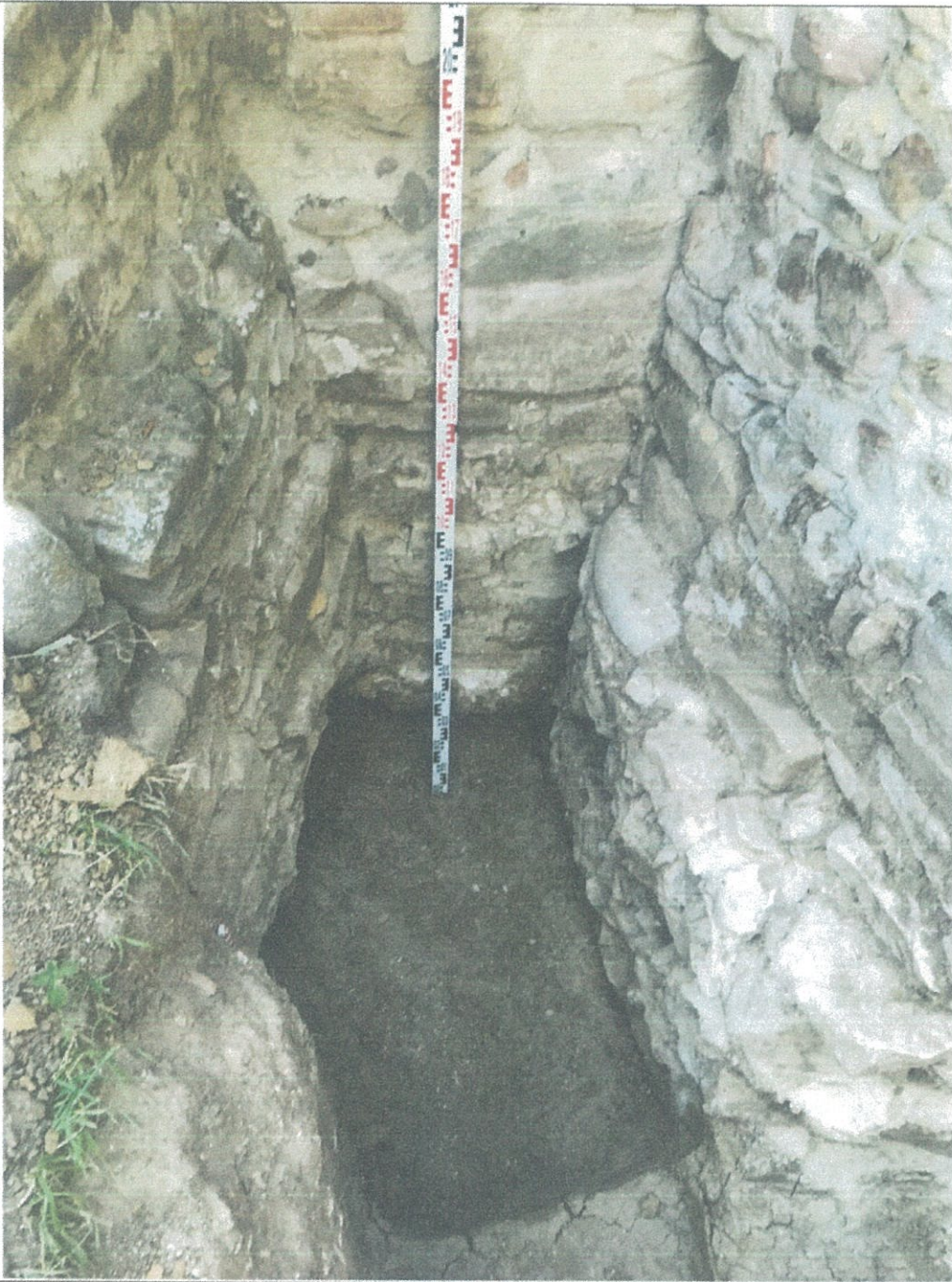
Fig. 14. C1 - detaliu cu fundațiile contraforților și relațiile acestora cu fundația corului
