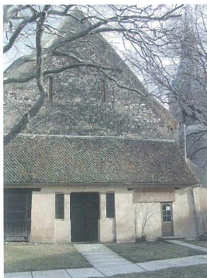
Fațada vestică, rămasă din biserica romanică
