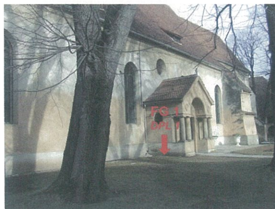
Fațada sudică cu localizarea forajului FG 1
